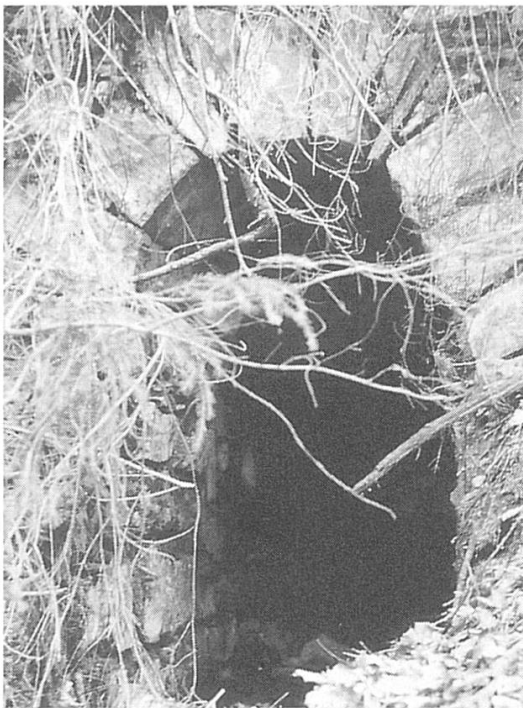
3 Entwässerungsstollen im Ägerti/Rosshimmel, gebaut im Jahre 1897 und 1898.
