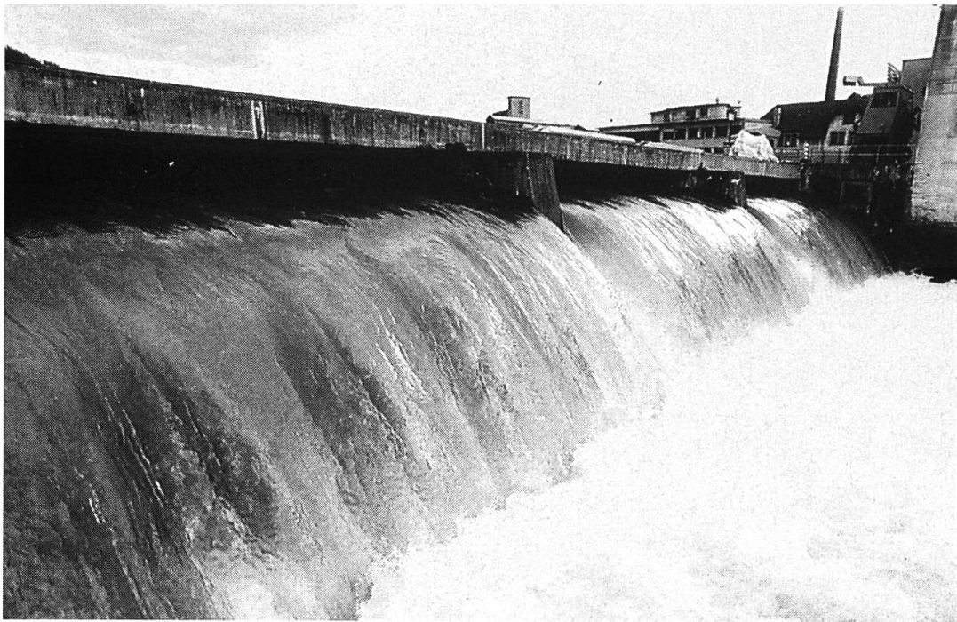
14. Mai: Kleiner Niagarafall beim Stauwehr des Thuner Elektrizitätswerkes. Hier flossen gestern bis zu 424 Kubikmeter Wasser pro Sekunde Richtung Bern. (Bild: Christian Ibach)
