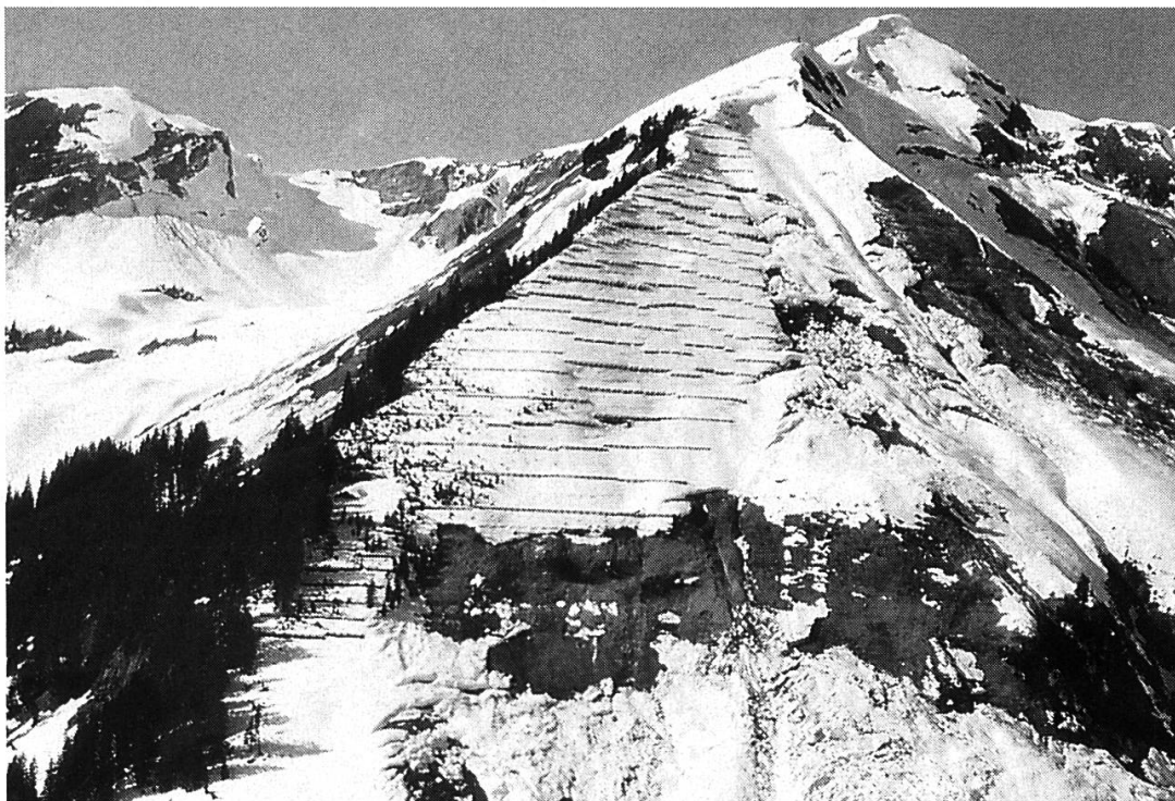
Lawinenverbauung Tanngrindel, Brienz
