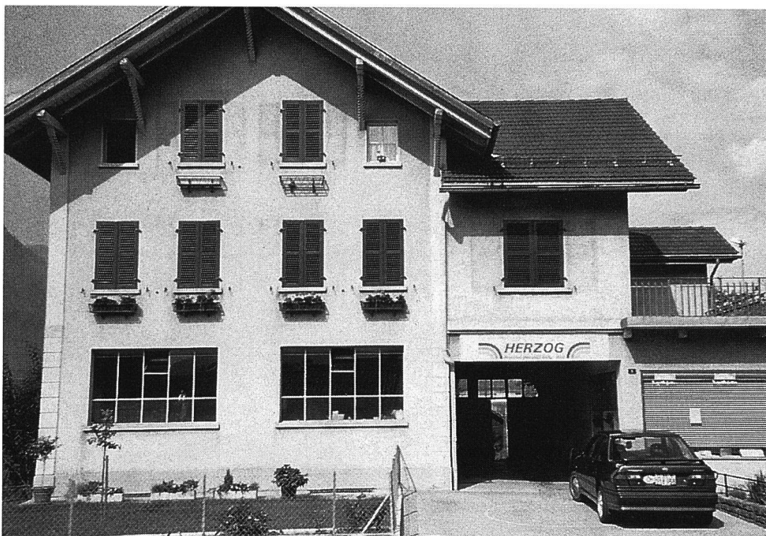
Abb. 6: Ehemalige Stockfabrik Bönigen
