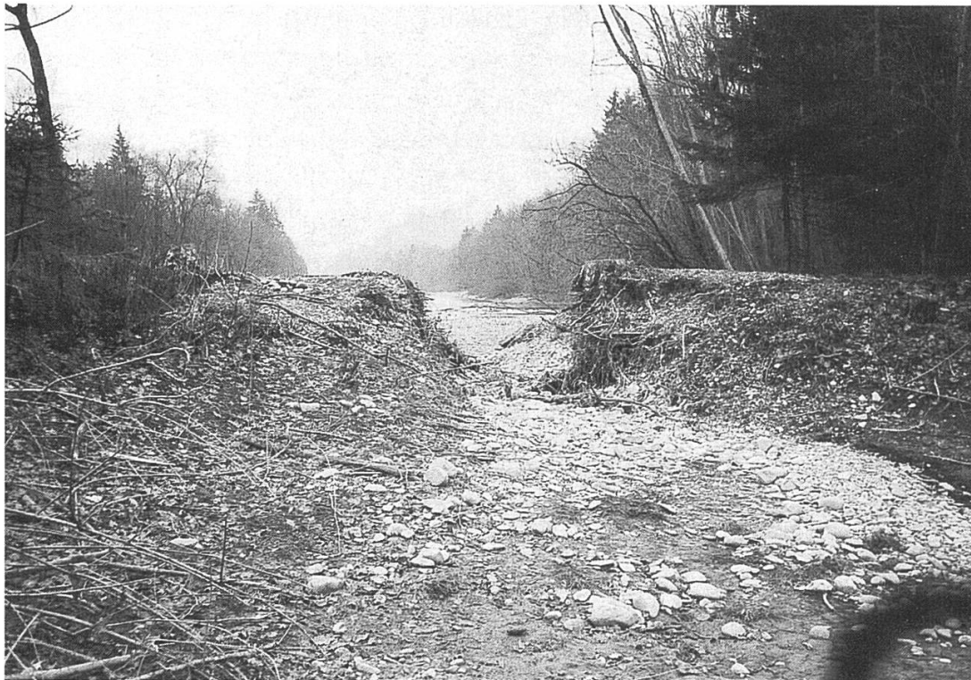
Belper Giessen: Dammdurchstich zur Aare.
