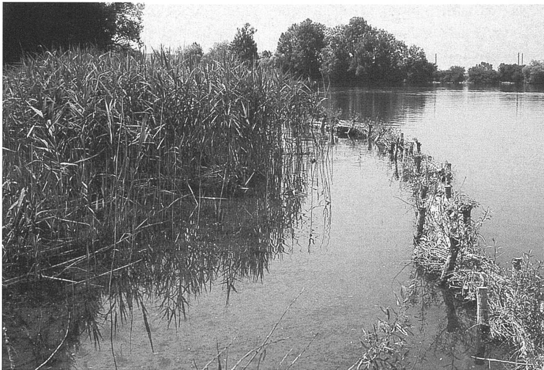
Schilfschutzmassnahmen durch Lahnungen.
