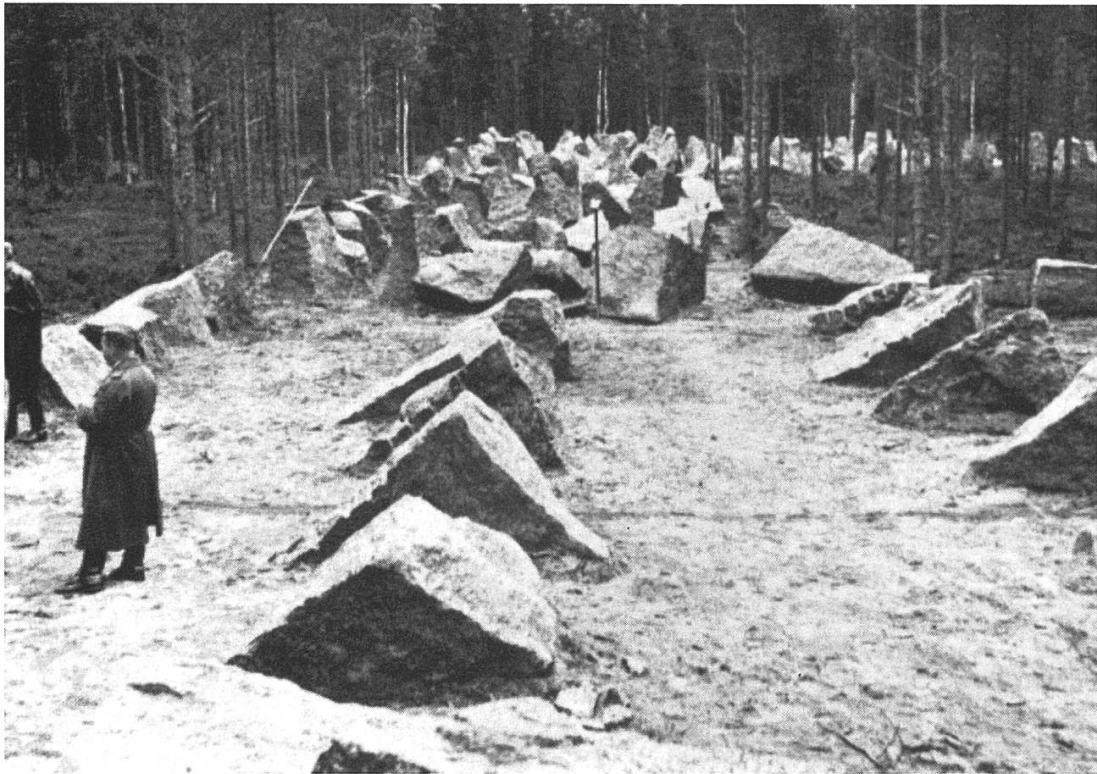
Panzerabwehrhindernis vor der Viipuri-Vuoksi-Linie im Bau.
