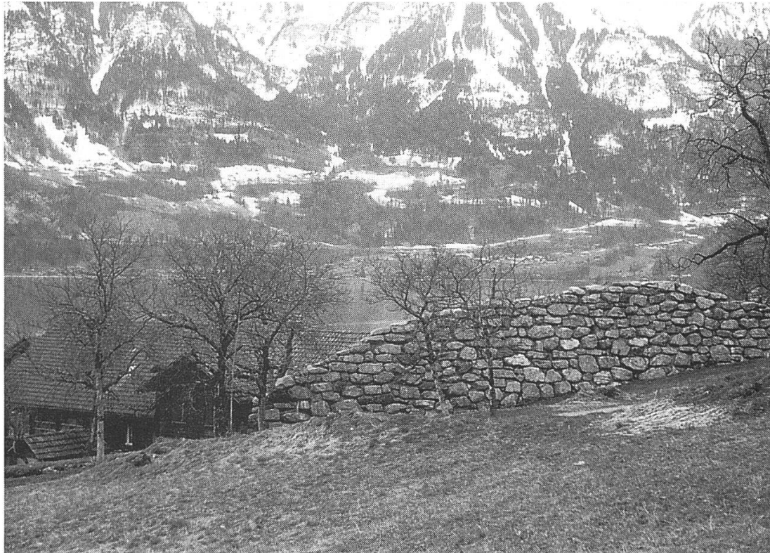
Abbildung 23: Eine Ablenkmauer von 25 m Länge und von bis 5 m Höhe schützt ein Wohnhaus im Auslaufgebiet der Lauigrabenlawine im Dörfli / Oberried.
