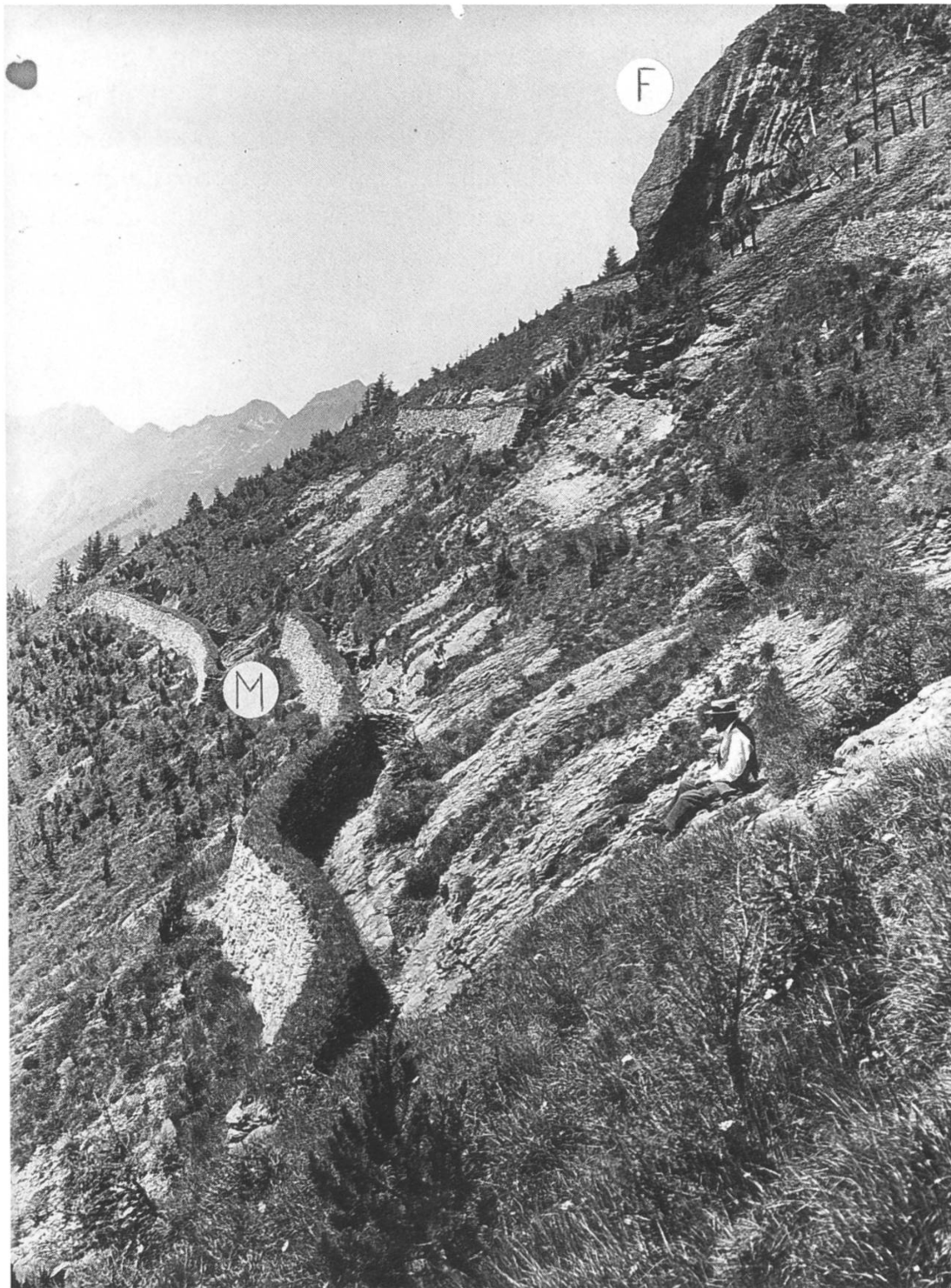
Abbildung 12: Alte Lawinenverbauungen mit freistehenden Trockenmauern in der oberen Urseren / Brienz 17—1800 m ü. M. Oben rechts Verpfählungen mit Profileisen. Schwierigste Aufforstungsbedingungen auf den flachgründigen Böden inmitten anstehender Felsplatten. F Felsgrind M Trockenmauern. Foto: 1911 Dr. F. Fankhauser.
