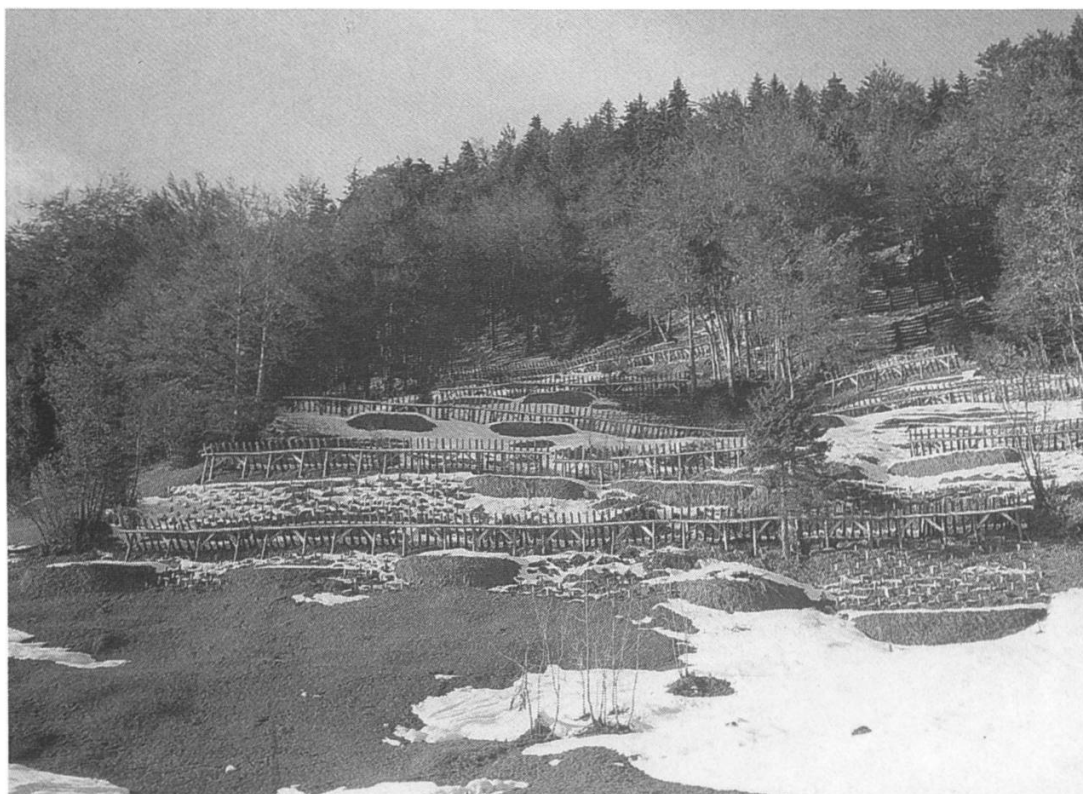
Abbildung 8: Die heute erfolgreich abgeschlossenen Aufforstungen der Lawinenanrissgebiete am Brünig wurden eingeleitet durch den Einbau von Holzschneerechen, begleitet von kleintechnischen Massnahmen gegen das Schneegleiten (Bermentritte und -teller, Erdterrassen und Verpfählungen). Aufnahme 1975.
