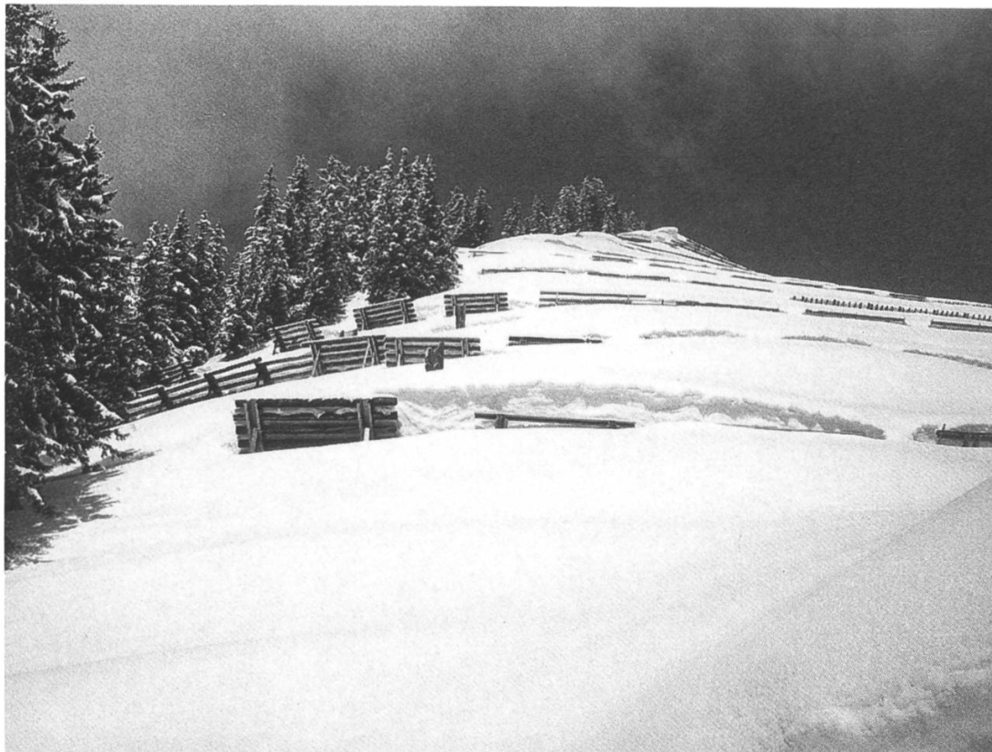
Abbildung 9: Stark eingeschneite Stützwerke am 21.4.1970. Die Aufforstung ist noch meterhoch von Schnee überdeckt.
