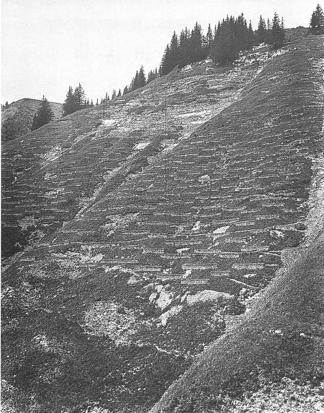
Abbildung 20: Kleine Trockenmäuerchen zur Ermöglichung der Aufforstung im Schwanderbach, ca. 1600 m ü. M.
