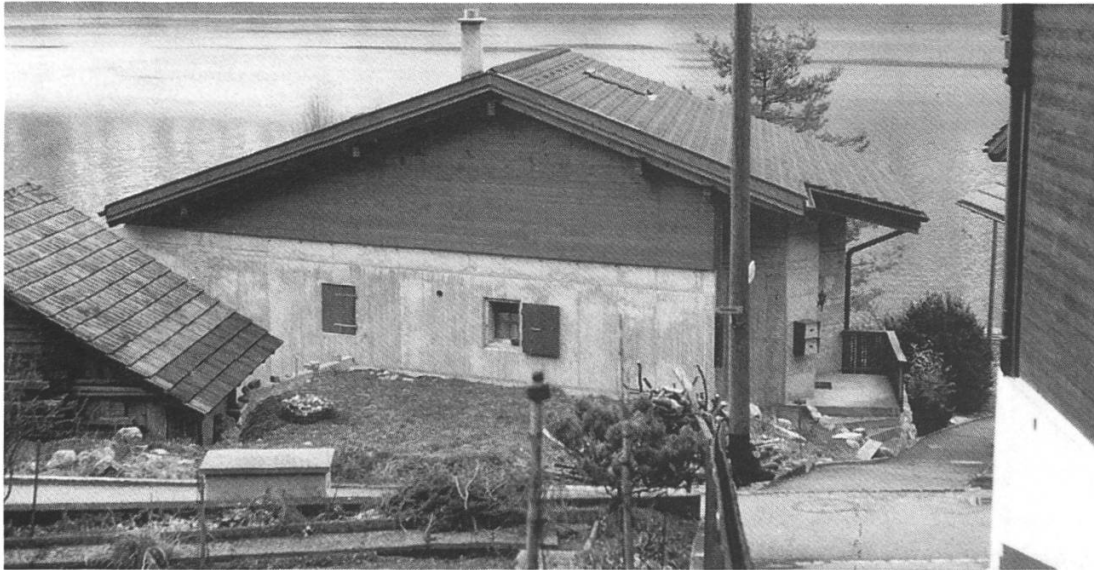
Abbildung 24: Direktschutz eines bestehenden Wohnhauses am Lauigraben / Oberried: Ganze berseitige Gebäudefronten in Eisenbeton und auf eine Lawinenkraft von 3,5 \text{ t/m}^2 dimensioniert (oberster Teil der Betonwand mit Holz verschalt); lawinenseitig keine Eingangstüren und höchstens nur kleine Fenster, die mit dimensionierten Fensterbalken geschlossen werden können; Verankerung der Dachpfetten in der Eisenbetonwand.
