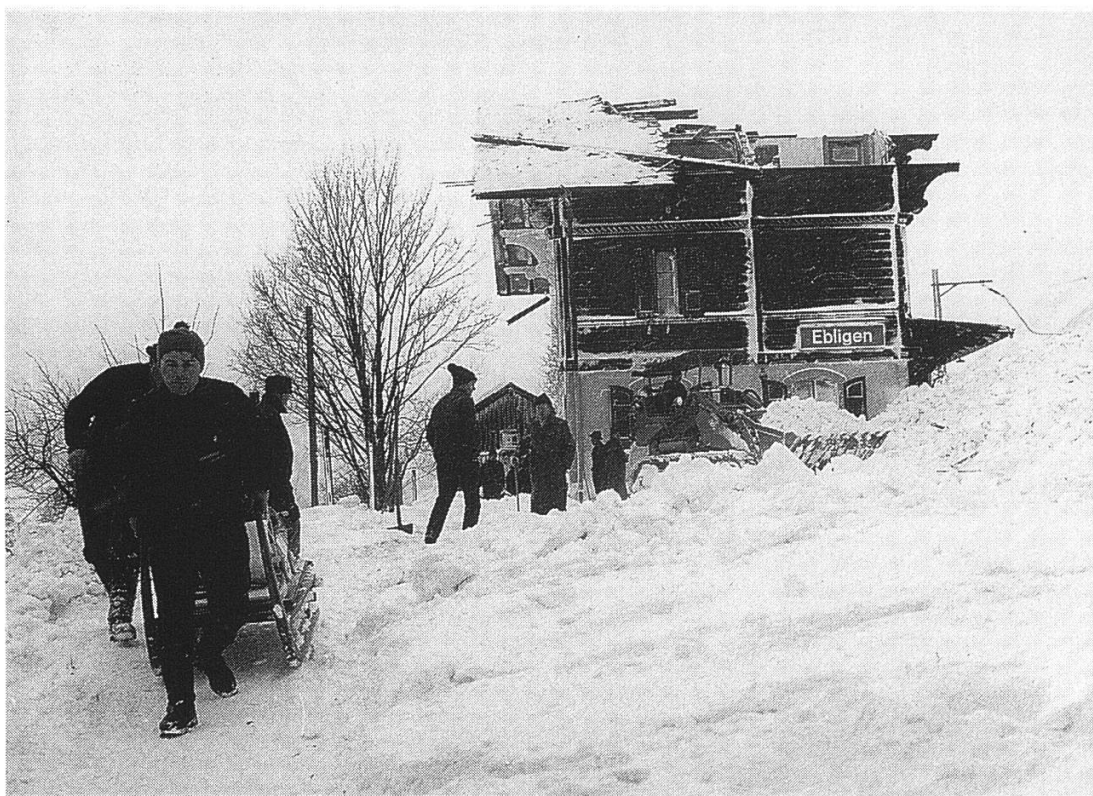
Abbildung 2: Am 8. Januar 1968 riss um 05.40 Uhr eine Staublawine aus dem Unterweidligaben dem Stationsgebäude von Ebligen das Dach weg und verschüttete die SBB-Linie auf eine Länge von 20 m.
