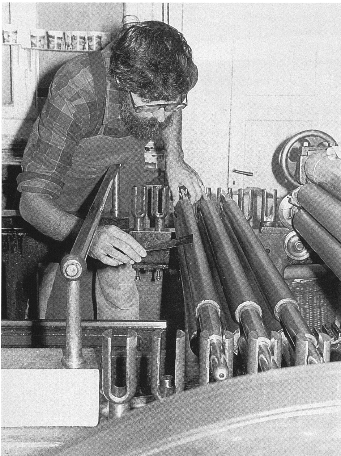
Der Druck-Künstler beim Aufstreichen von Farbe in die Steindruck-Schnellpresse.
