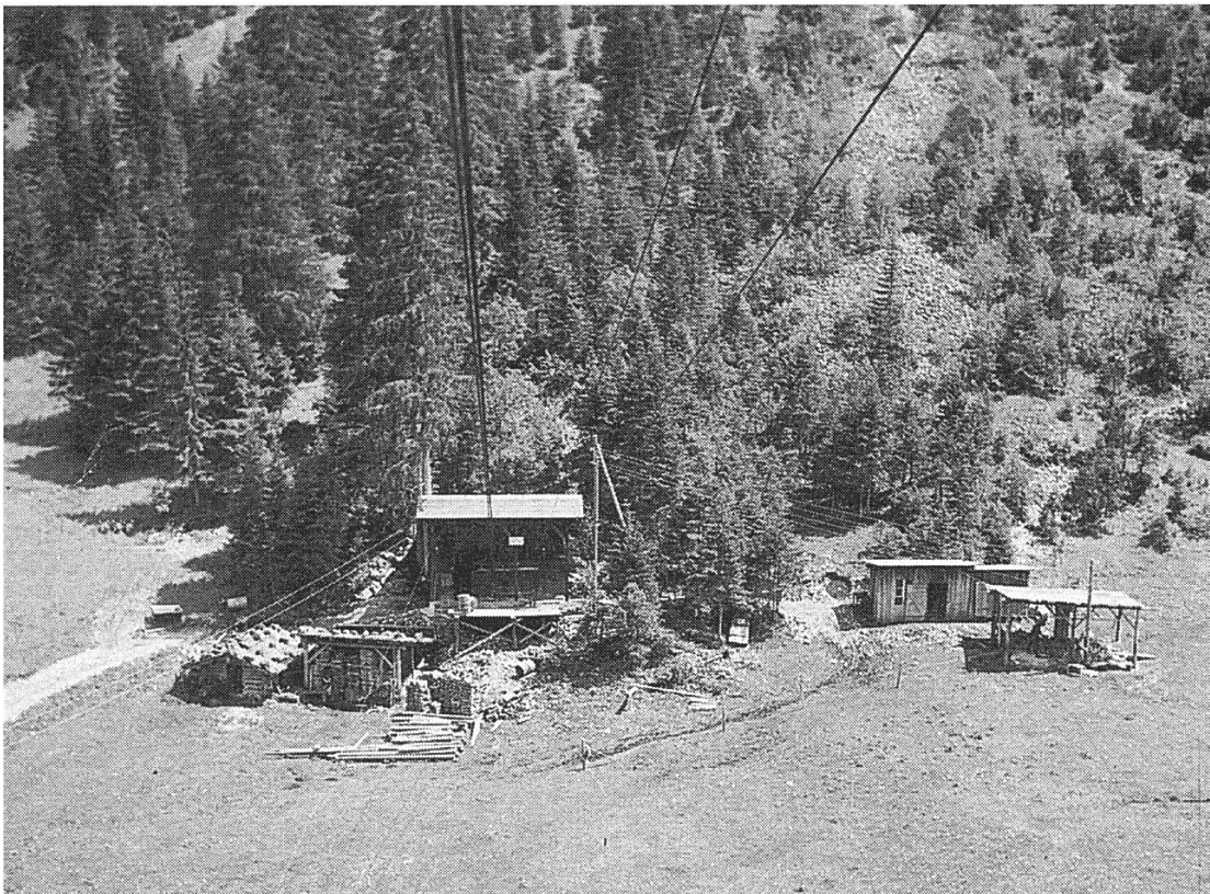
Die Talstation kleines Mittelbärgli
