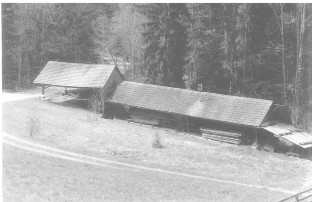
Abb. 4. Säge Gesamtansicht. Blick aufs Cholerebödeli von Osten. Die Saagi wurde 1858 erbaut, der Ladeschopf (links) 1930. Aufnahme 1990
