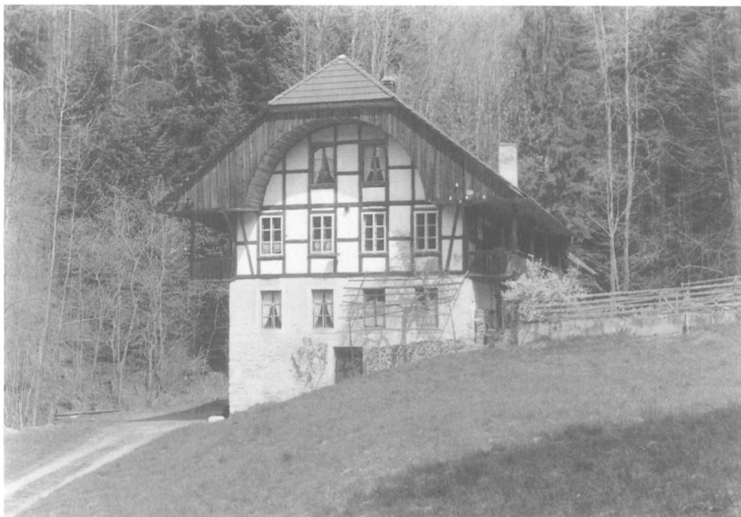
Abb. 1. Choleremüli; Baujahr 1864. Beeindruckend ist die grosszügige, schlichte Bauweise; auf dem mächtigen Mauersockel der Mühle ruht der Riegbau (Wohnteil und Estrich). Aufnahme 1990
