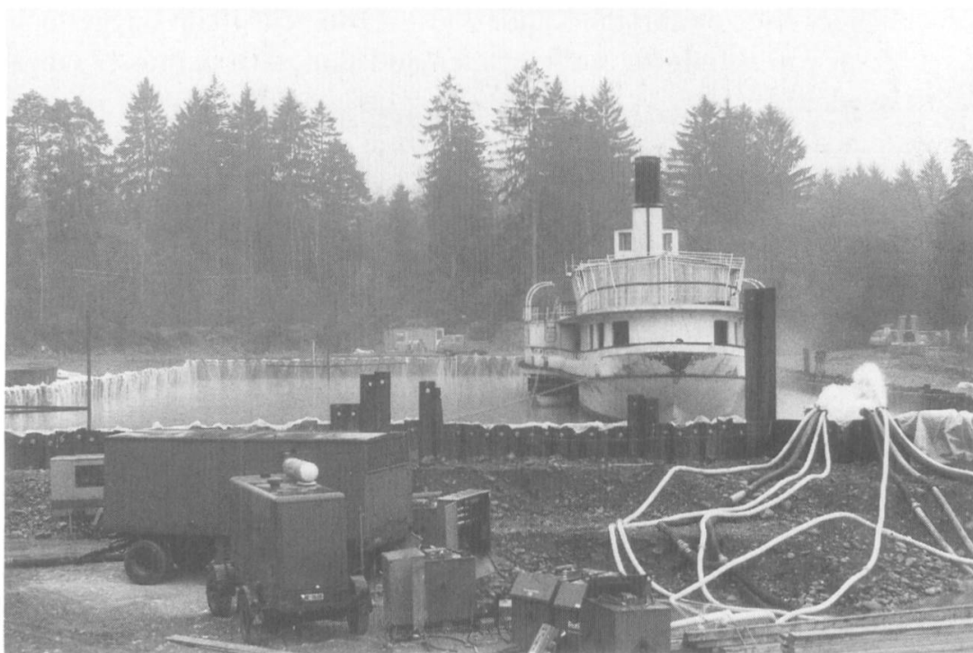
Abb. 4: 54 000 Minutenliter Seewasser werden ins abgedichtete Dock gepumpt und heben das 300 Tonnen schwere Schiff.
