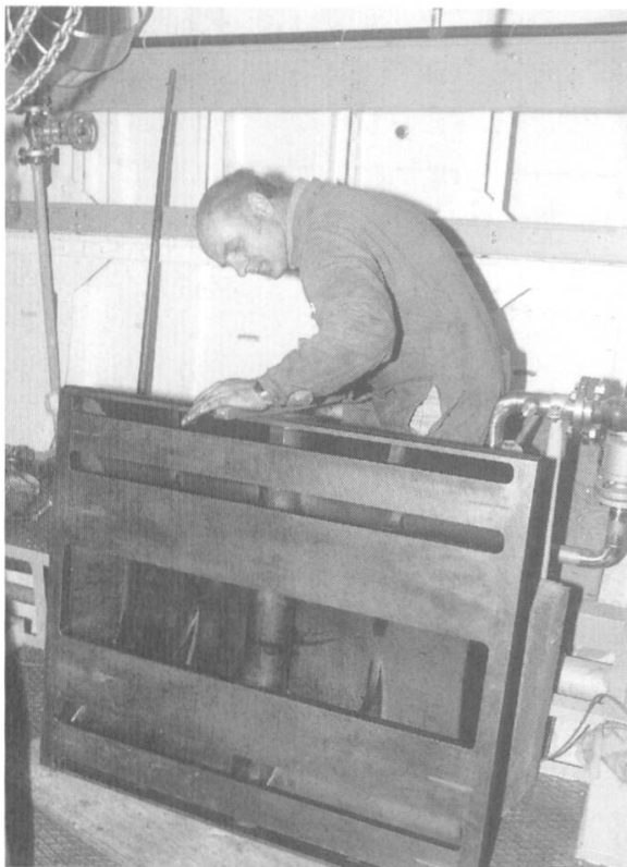
Abb. 15: Werner Steiner, verantwortlich für die Revision der Dampfmaschine, an der Arbeit am Niederdruckschieber.
