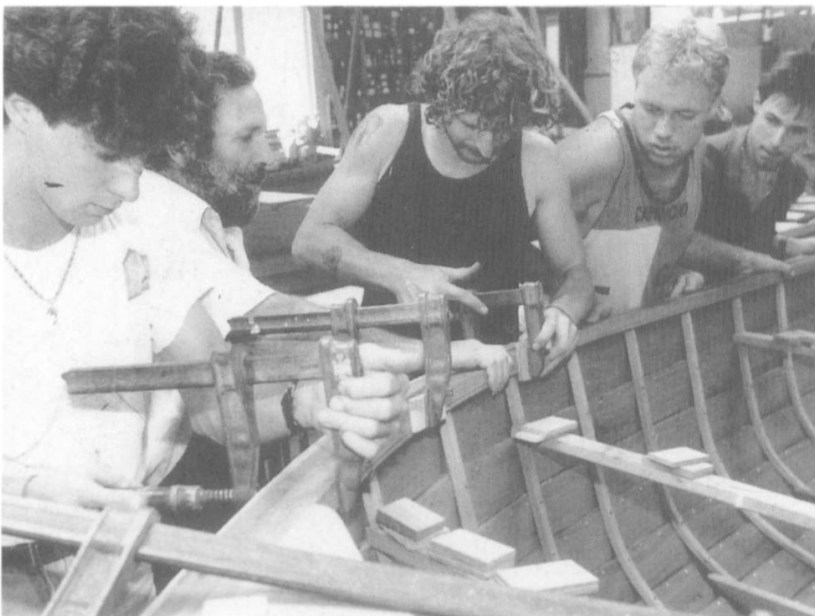
Abb. 14: Unter Anleitung von Heinz Glasl (2. v. l.) arbeiten Bootsbauerlehrlingen an einem der beiden original nachgebauten Rettungsboote. Foto: H. R. Dütschler/Vaporama, 23. August 1991
