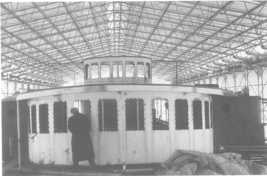
Abb. 10: Die provisorische Überdachung der Baustelle ermöglicht die Fortsetzung der Arbeiten im Winter 1990/91.
