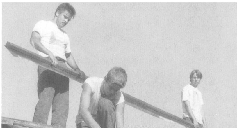
Abb. 12: Spenglerlehrlinge verlegen Alubleche auf dem Dach des Oberdeck-Restaurants. Foto: W. Wanzenried, Thun
