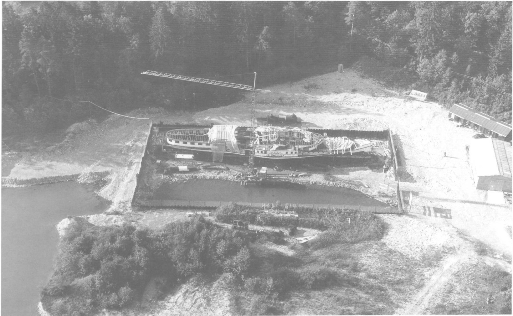
Abb. 1: Ein Aufklärer der Luftwaffe nimmt am 24. August 1990 die Baustelle im Kandergrien auf einem Übungsflug auf. Foto: Hans Ruckli, Nürensdorf
