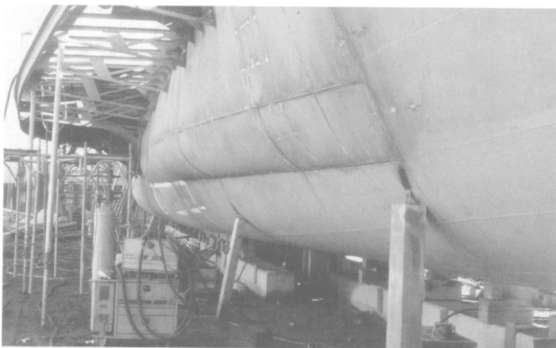
Abb. 9: Seitliche Ausbuchtungen an der Schale des Vorderschiffs verbessern die Seitenstabilität.
