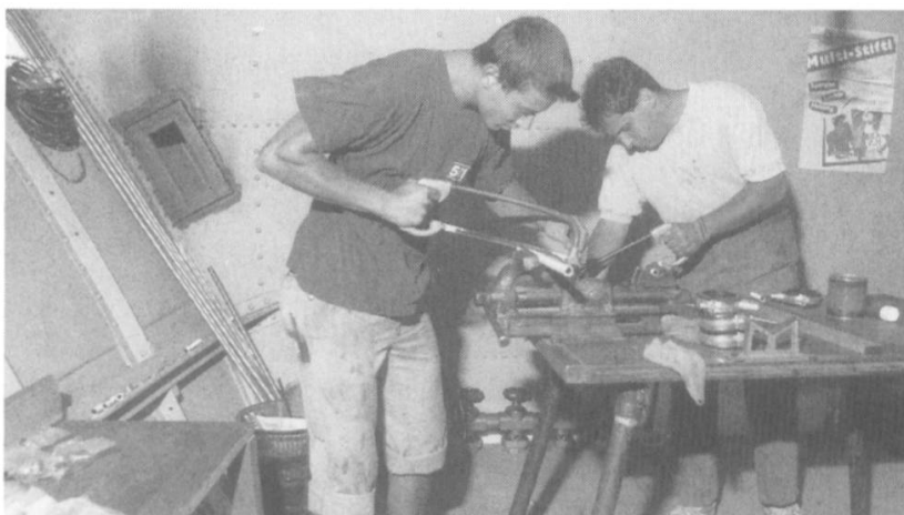
Abb. 13: Ungeohnter Arbeitsplatz für Sanitärinstallateurlehrlinge im Rumpf der «Blümlisalp». Foto: W. Wanzenried, Thun
