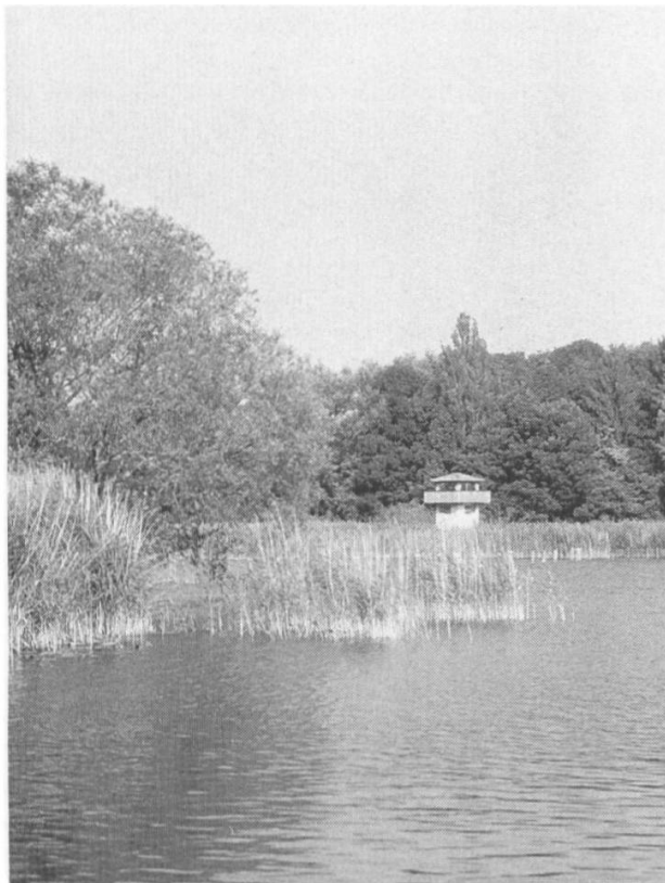
In den Jahren 1938—1940 wurde im Gwattlischenmoos der Beobachtungsturm («röm. Wachturm») gebaut. Der UTB bezahlte den Turmbau, das Fernrohr und 60 m Laufsteg. (Foto P. Blaser)
