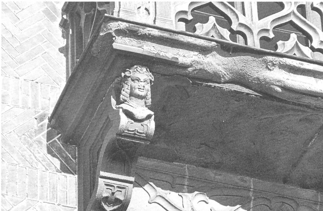
Fassadenteil vor der Renovation
