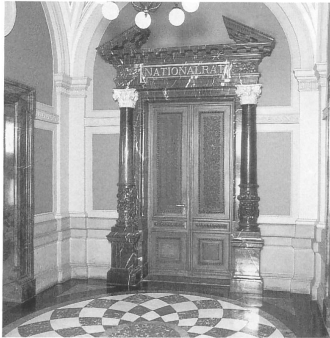
Bild 17 Türgewände aus Kalkstein von Brienz im Parlamentsgebäude Bern.
