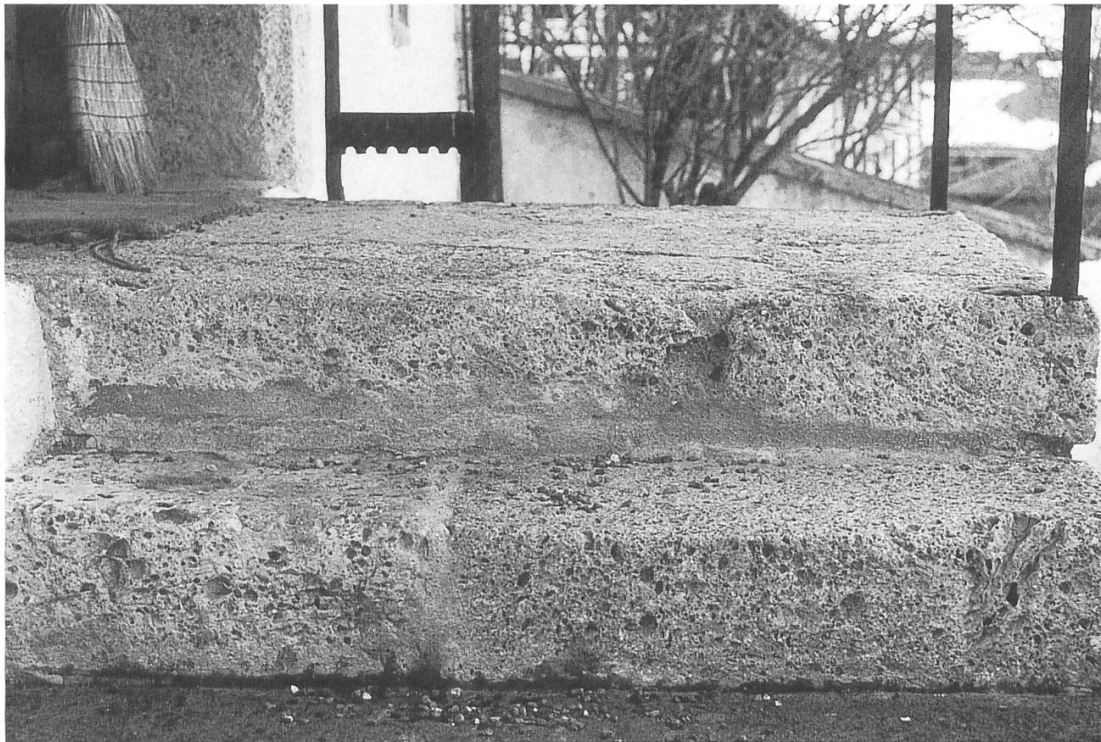
Bild 26 Kirche Saanen: Treppenstufen aus Rauhwacke.
