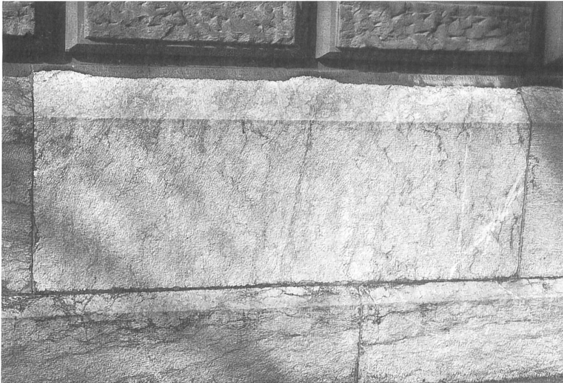
Bild 3 Sockelband aus Merliger Stein am Bundeshaus West.
