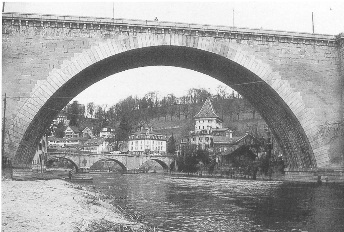
Bild 29 Brückenbogen aus Aaregranit an der Nydeggbücke in Bern.
