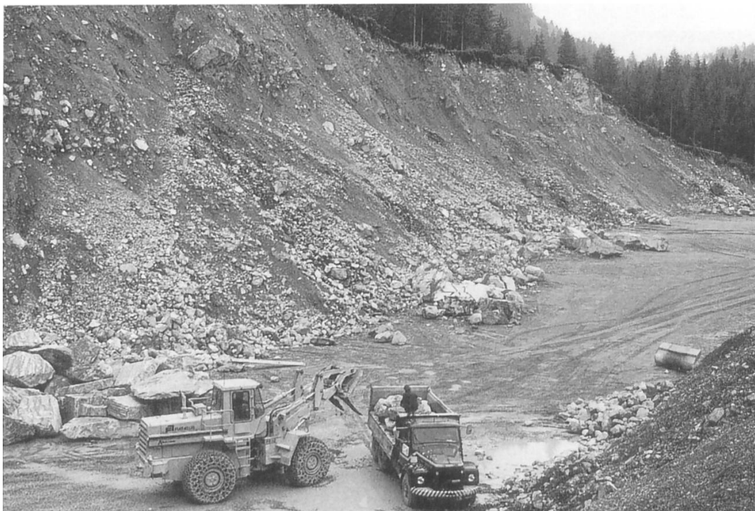
Bild 25 Gewinnung von Kieselkalk bei Blausee-Mitholz aus den Trümmernassen des Kandersteger Bergsturzes.
