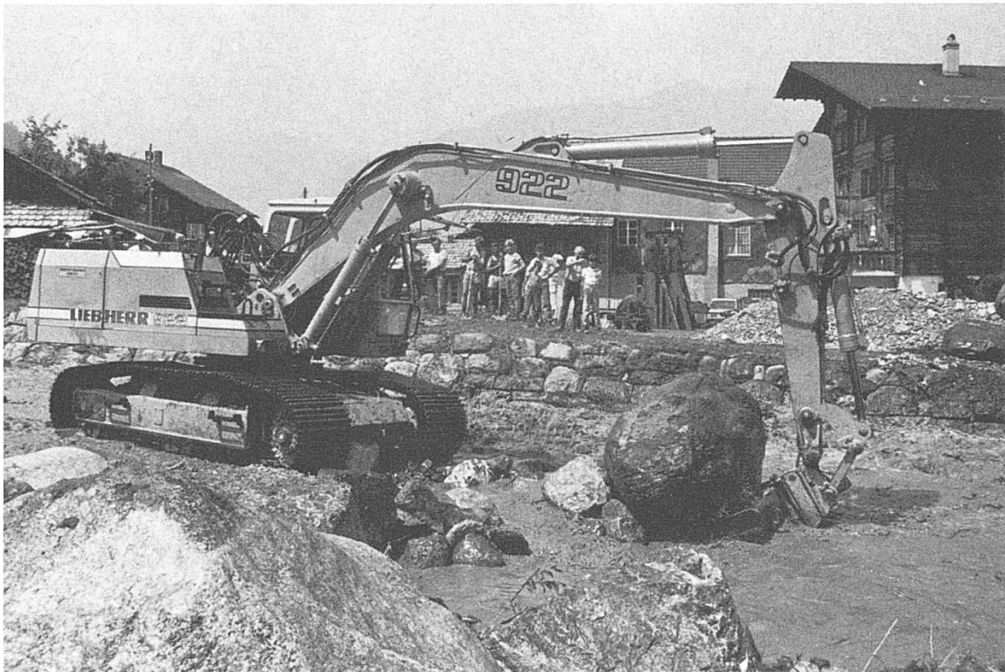
Sommer 1987 Bachräumung von Felsblöcken oberhalb der Sandbrücke
