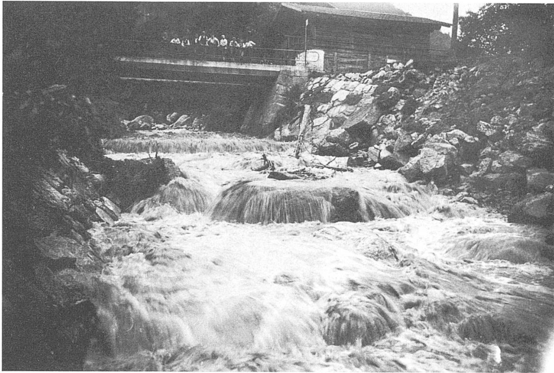
Sommer 1931 Der weggerissene Damm unterhalb der Mühlebrücke
