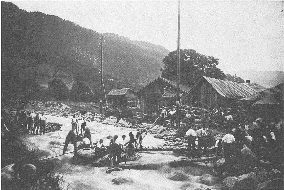
Sommer 1931 Sprengarbeiten auf dem Sand
