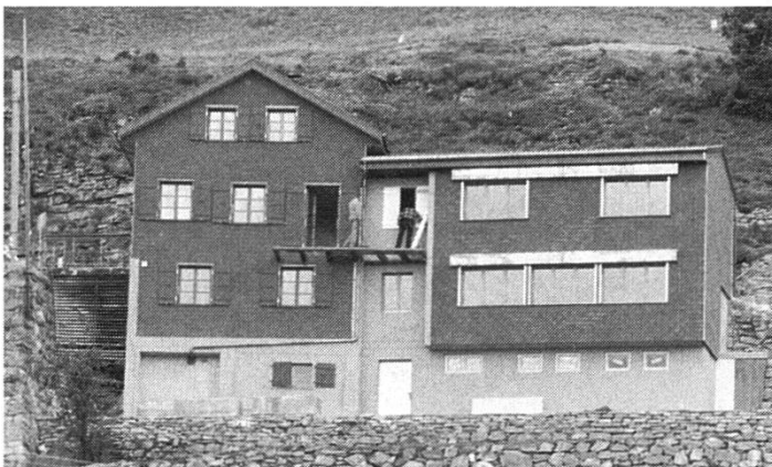
Renoviertes Haus des Alpengartens mit Erweiterungsbau.
