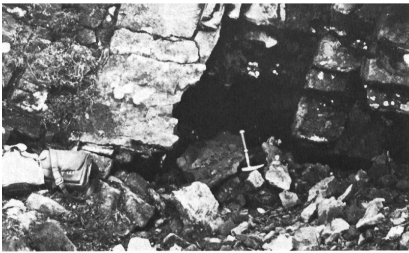
◀ Bild 4: Eingestürzter Eingang eines Kohlenstollens am Nieder- horn
