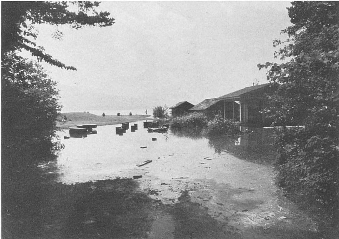
Infolge des Hochwasserstandes im Vorsommer 1978 wurden die Arbeiten verzögert. Im Vordergrund das bereits im Rohbau erstellte Toilettengebäude.
