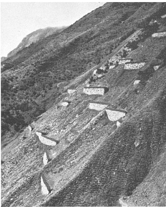
(5) Bandriseten (Lammbach), Zustand der Verbauungen und Aufforstungen 1939
