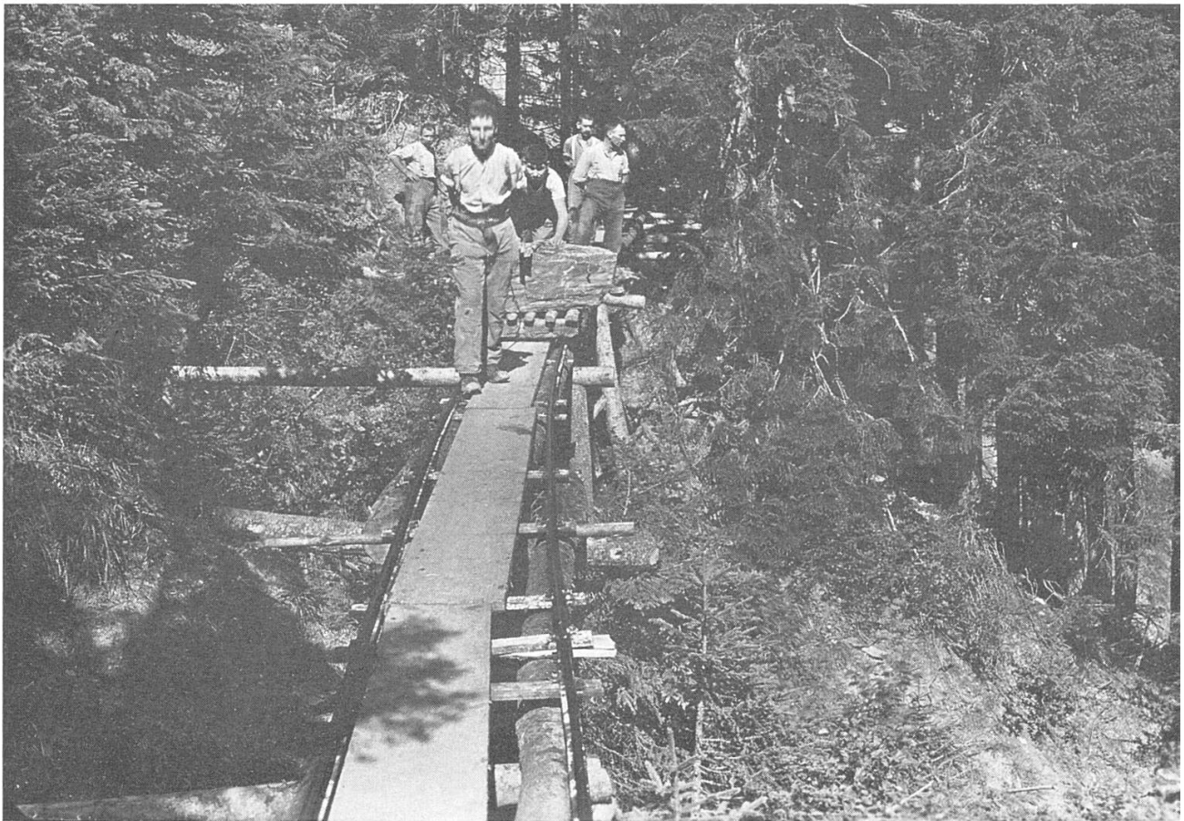
(2) Bau einer Mauer um 1934. Transport von Mauersteinen mit einer Rollbahn.
