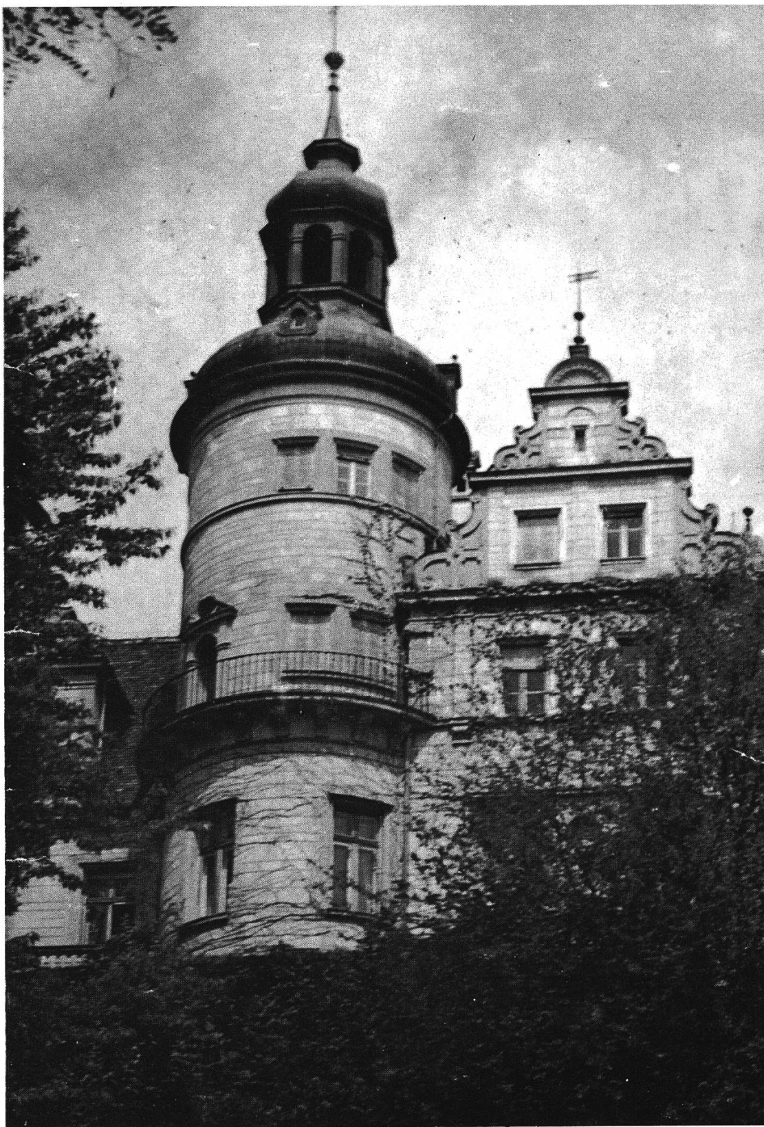
Mittelbau des Schlosses Chartreuse
