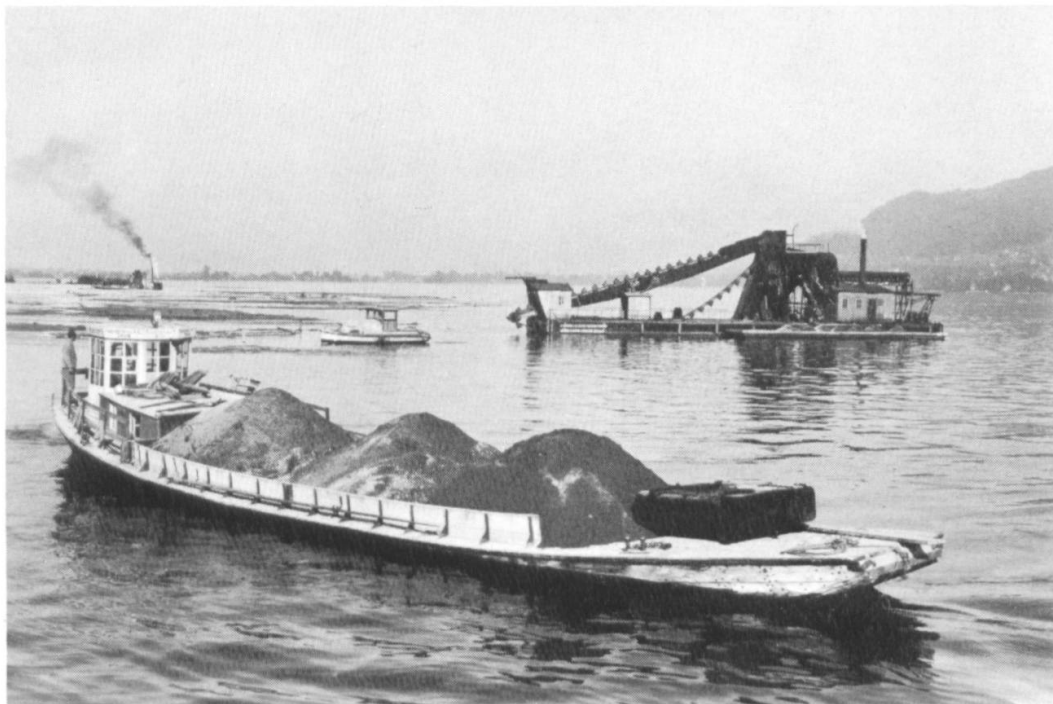
Abb. 2: Kiesgewinnung 1937. Im Vordergrund ist ein Transportschiff (im Volksmund "Kanderbock" genannt) und dahinter sind zwei schwimmende Dampfbagger sichtbar.
