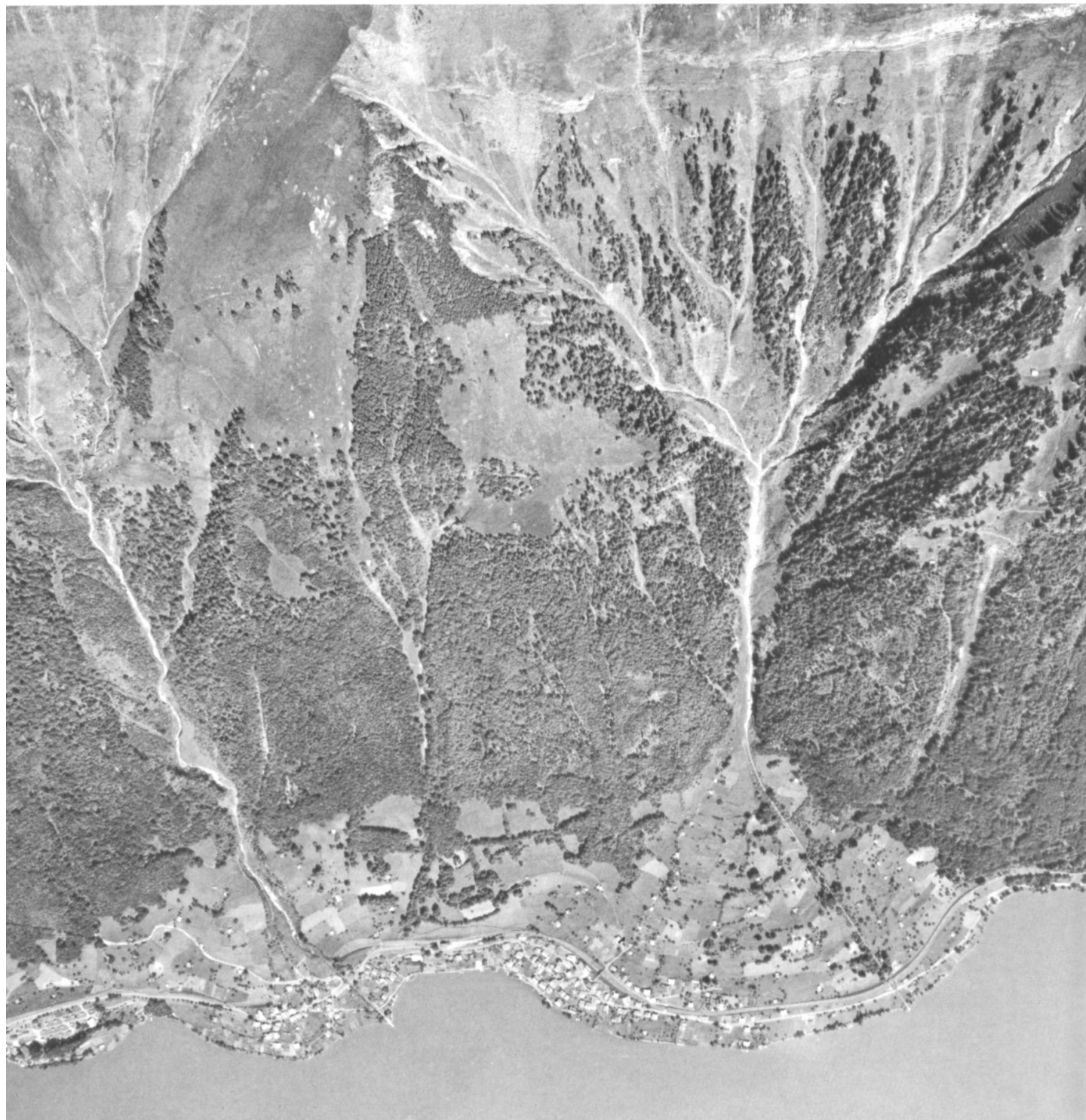
Luftaufnahme von Oberried. Der ganze Ostteil des Dorfes liegt unter dem schützenden Wald auf dem Schuttkegel des Hirscherengrabens, dessen Einzugsgebiet im oberen Teil nicht bewaldet ist. (Publikation mit Bewilligung der Eidg. Vermessungsdirektion vom 7. November 1968)
