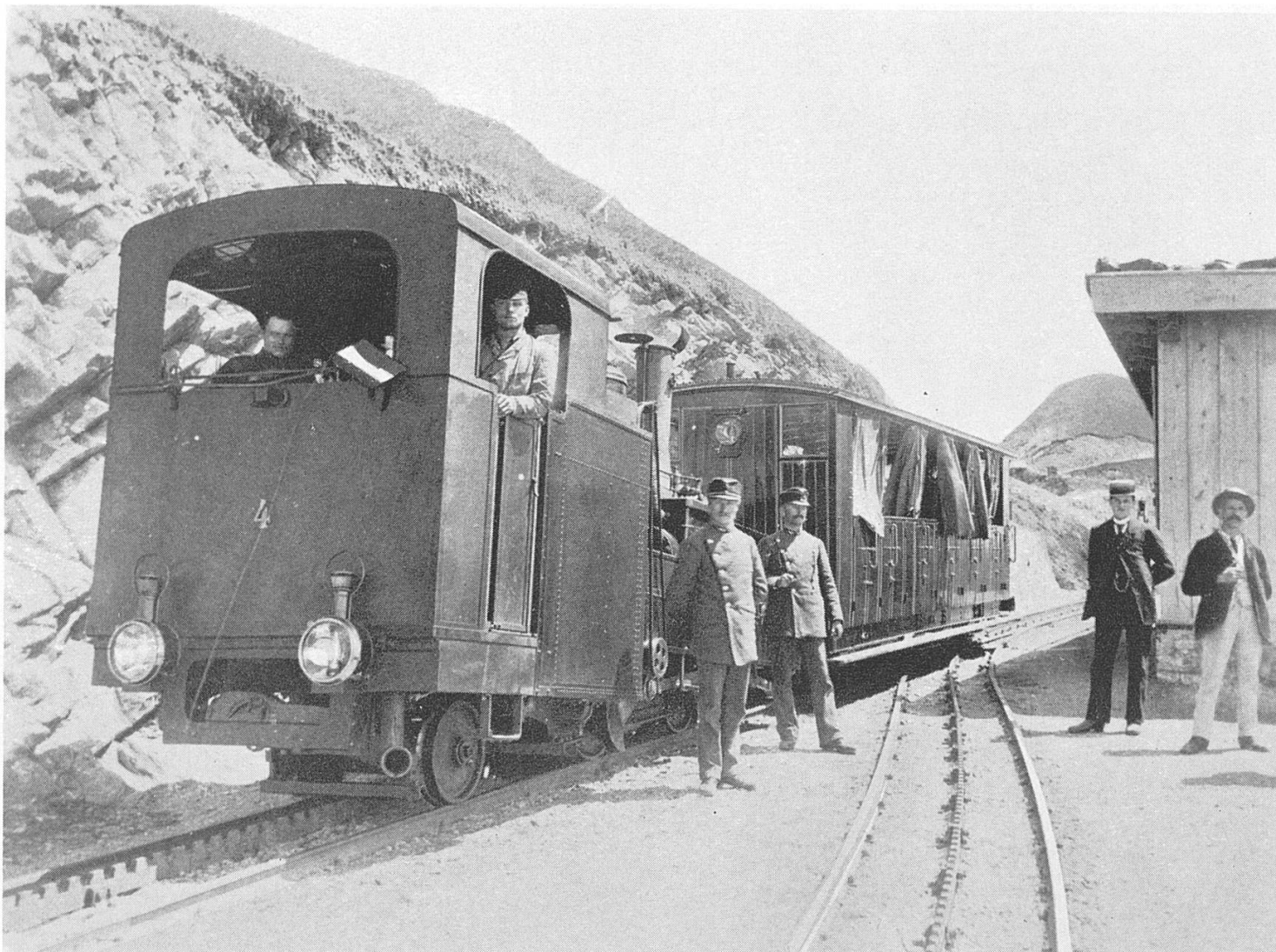
Auf Rothorn-Kulm um 1895. – Die BRB-Lokomotiven Nr. 2 – 5 wurden 1935/36 von Naßdampf auf Heißdampf umgebaut. (Sammlung Chr. Lüber, Brienz)
