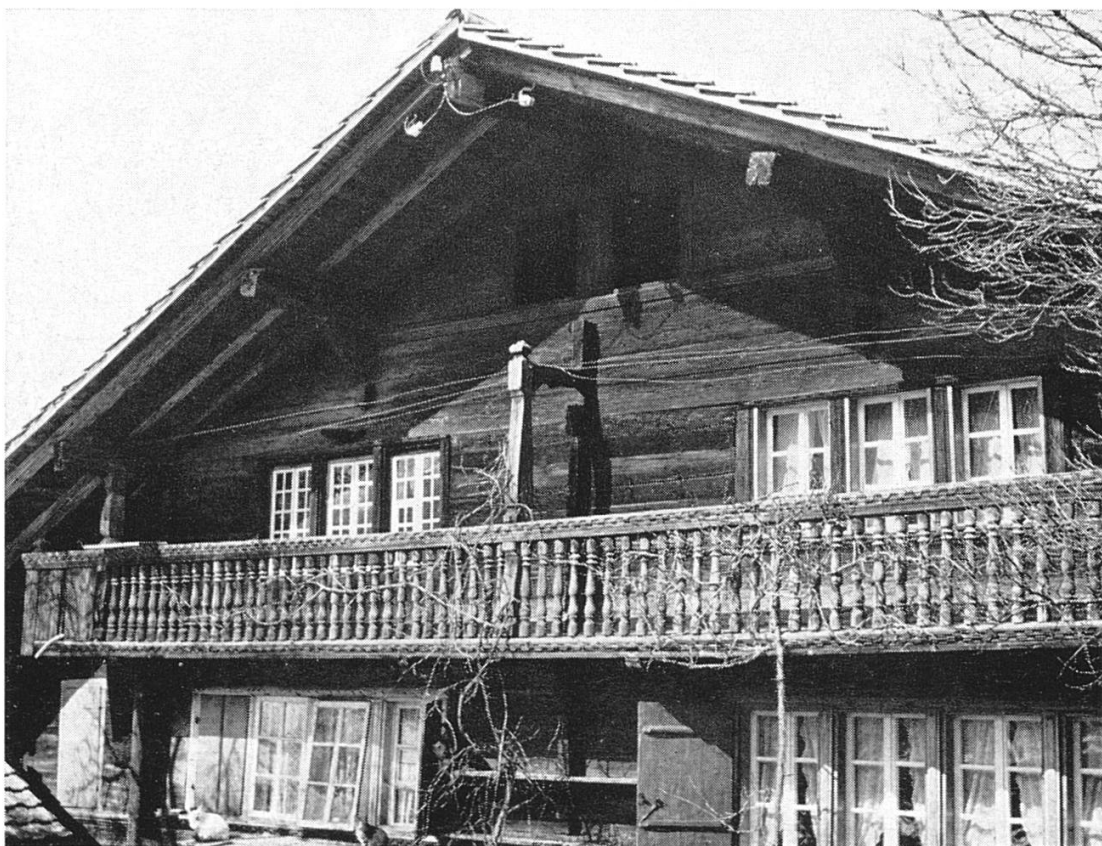
Südfassade des Hauses Frl. M. Mühlemann / Werner Brand mit ursprünglicher Fensteranordnung. Einzige noch erhaltene Frontlaube mit Würfelfries und gedrehten Stäben als Lehne. Schön geschnitzter Mittelpfosten. Die schmale Laube diente zum Wäschetrocknen und Dörren von Obst und Bohnen.
