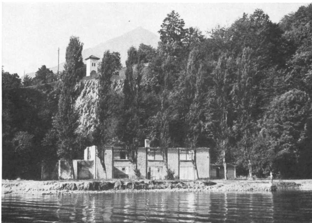
Faulensee, Ruinen einer Gipsfabrik
