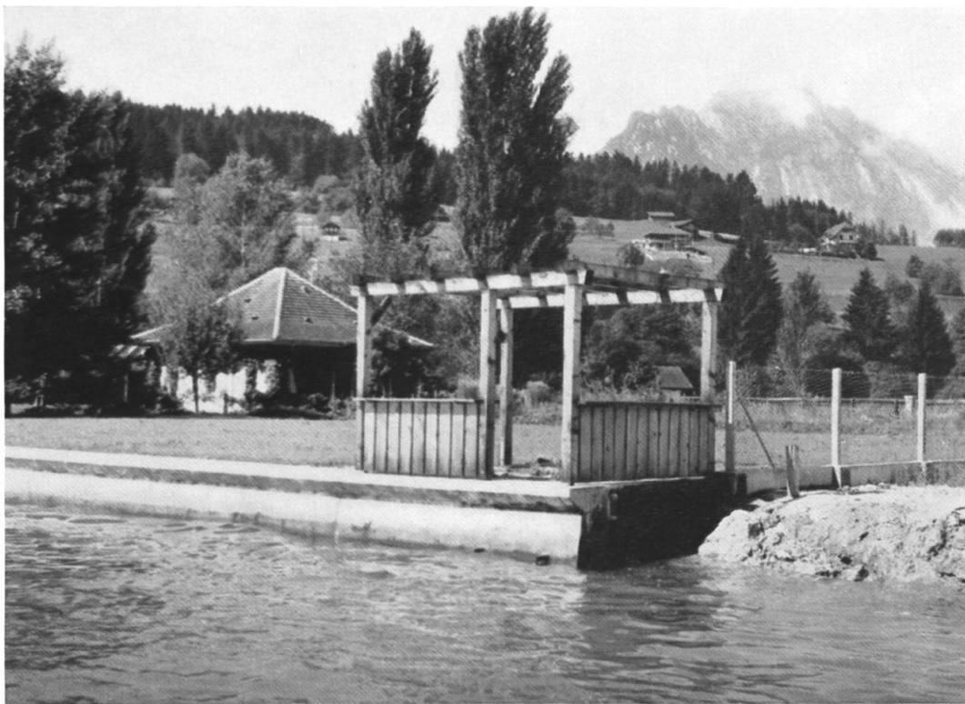
Beton-Mauern als Ufersicherung müssen wir ablehnen P. Howald
