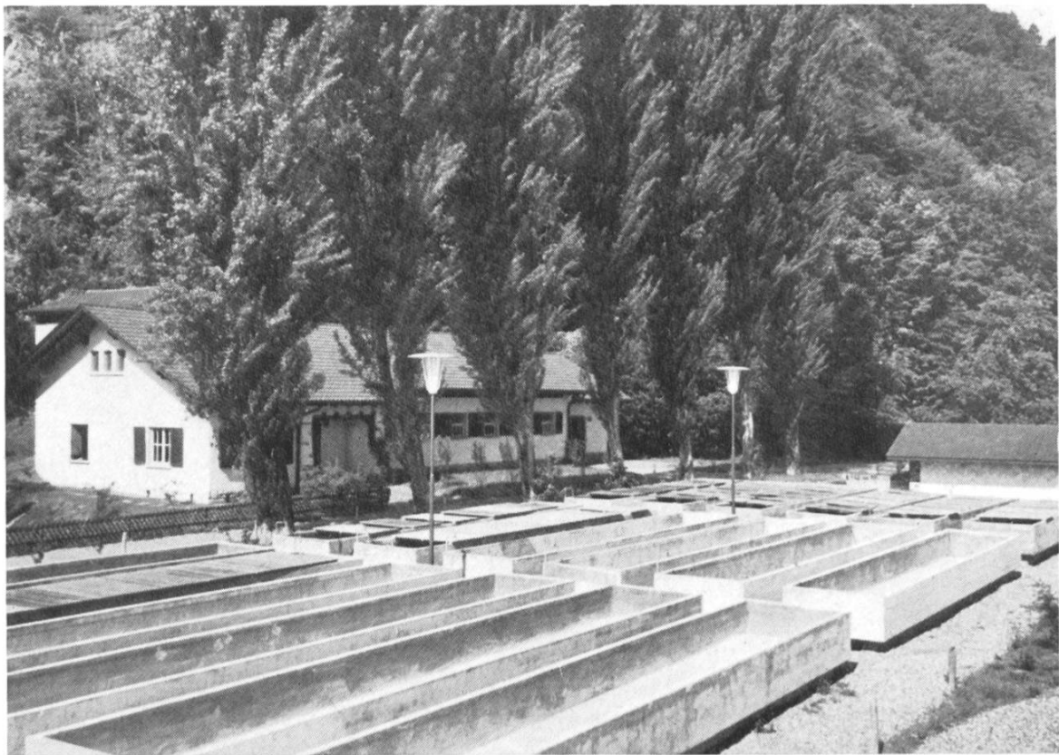
Faulensee, neue Fischzuchtanstalt an Stelle der alten Gipsfabrik Wir wirkten bei der Platzgestaltung mit
