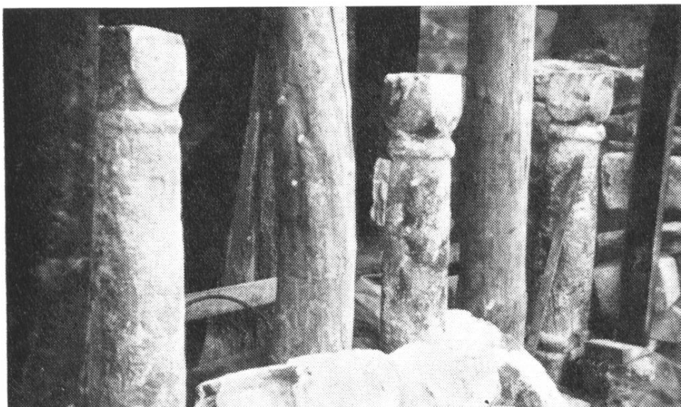
Vierteiliges Fenster (Seeseite): am alten Standort stehende Säulen
