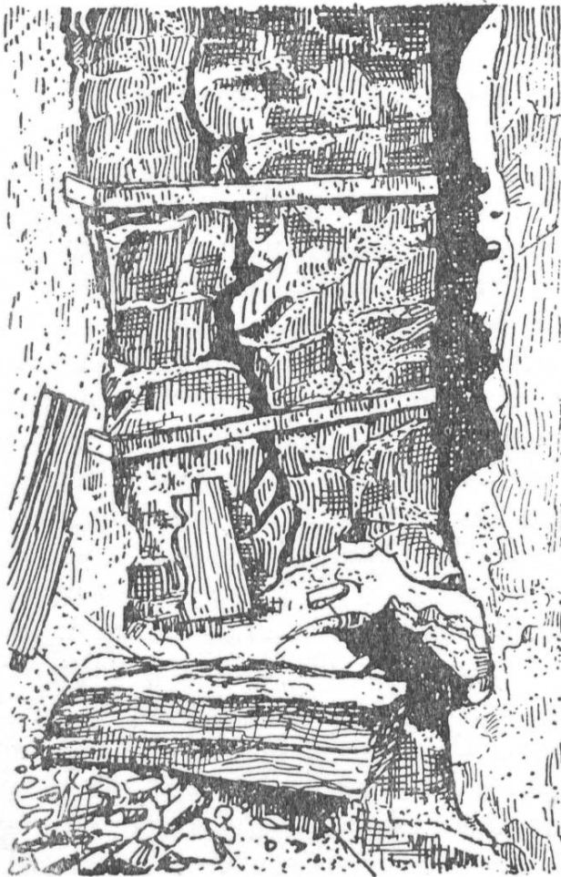
Fensteröffnung mit längsgerissenem Mauerwerk mit Bandeseisen notdürftig zusammengehalten, nach der Wiedereröffnung
