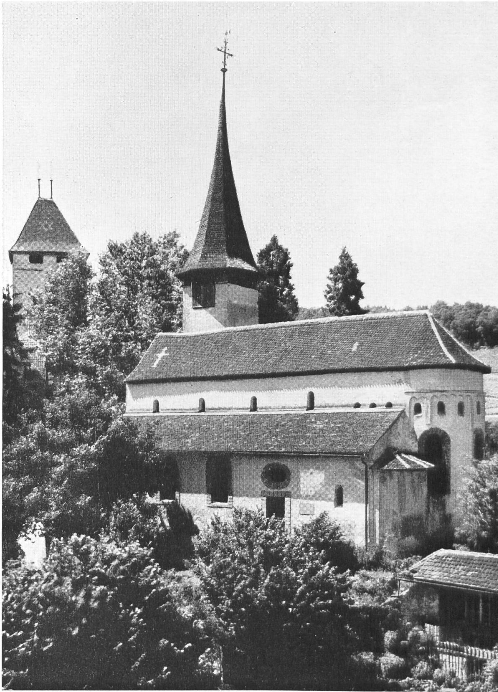
Ansicht von Südosten vor der Restaurierung
