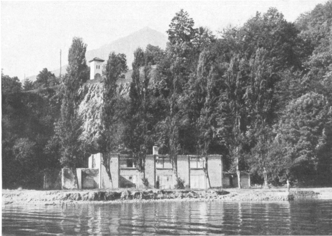
Ruinen der Gipsfabrik Faulensee
