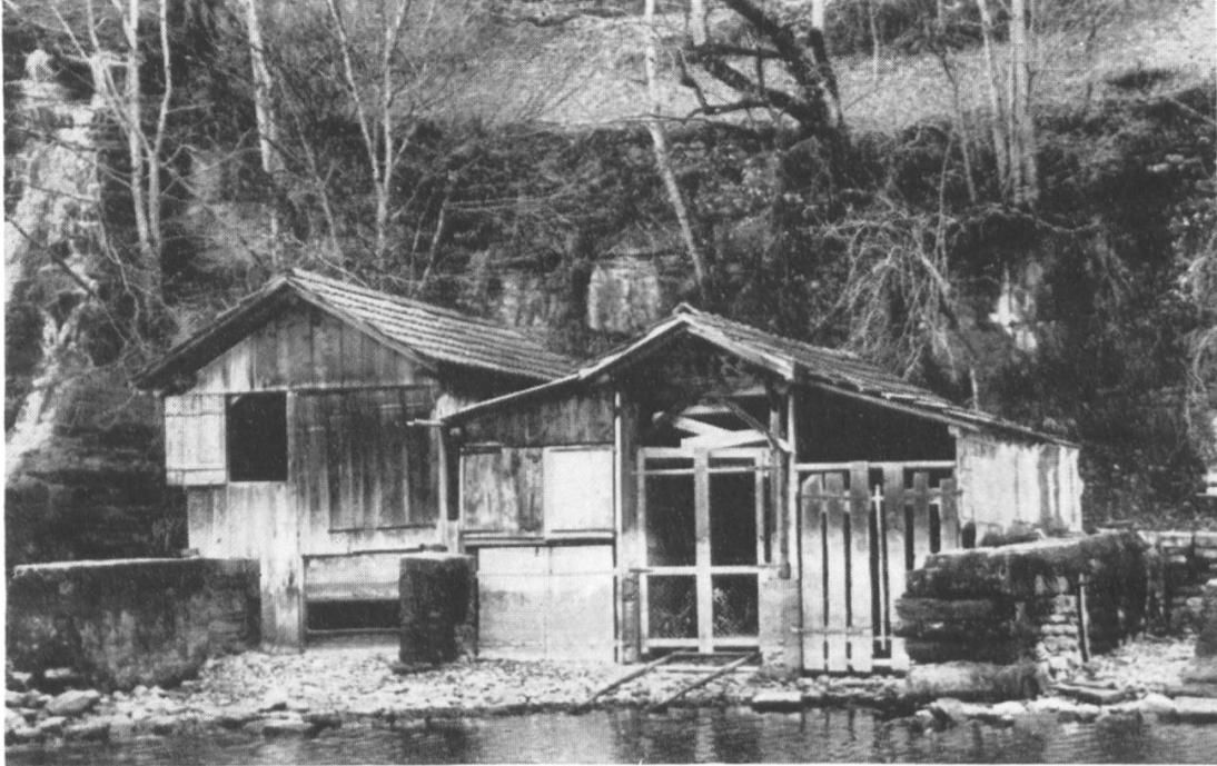
Bild 10 Schlechtes Beispiel, verlotterter Zustand
