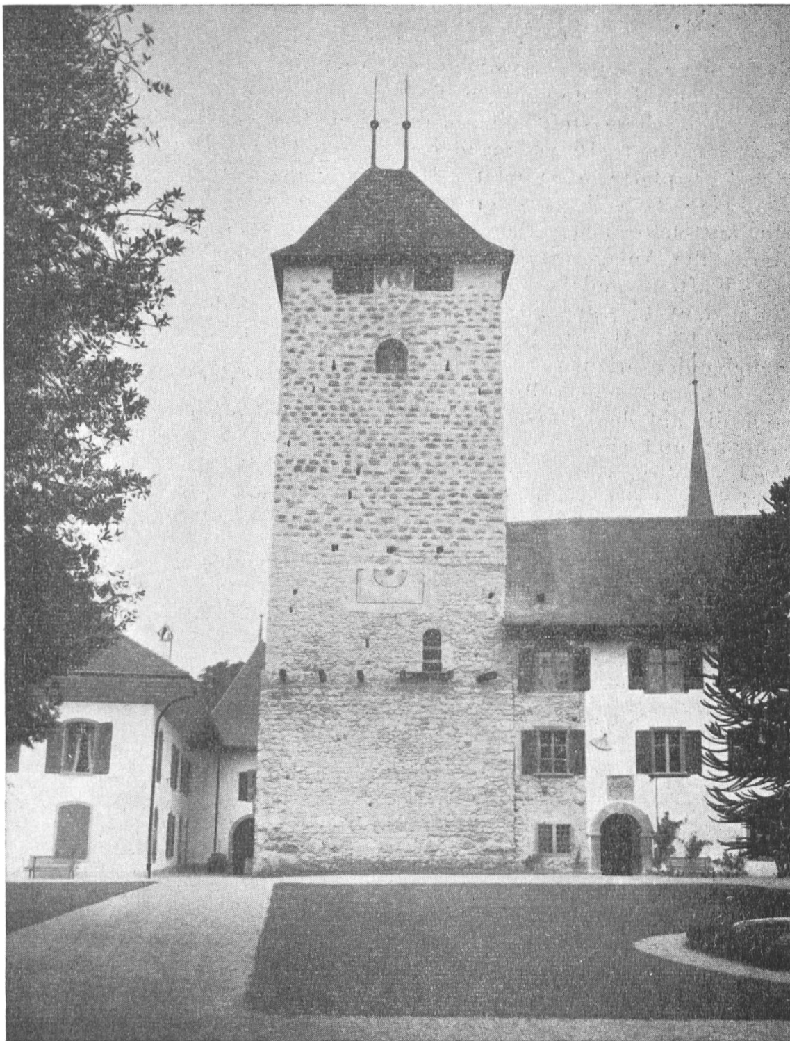
Abb. 9 Ansicht des renovierten Turmes von der Hofseite aus gesehen. Man beachte die beiden Mauertechniken. Rechts der vom Verputz abgedeckte Verbindungsbau zwischen Turm und Palas
