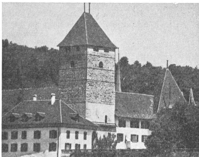
Abb. 7 Vor der Renovation: Turmansicht mit Eisenspangen, Verputz und Vordächli
