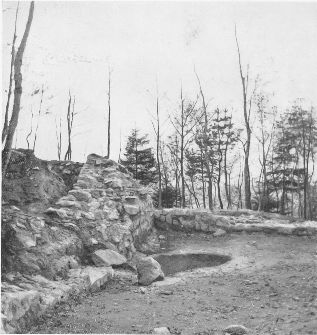
Die Burgruine Lunkhofen, Blick von Nordosten.
