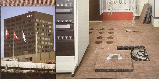
NCR-Verwaltungszentrale, Zürich-Wallisellen: 2000 m² Alpina «Gigant-Tweed Velours», verlegt in Form von schnittfest ausgerüsteten Platten auf Doppelboden. Die einzeln belegten und entfernbaren Bodenelemente ermöglichen mühelosen Zugang zu den darunterliegenden Leitungen.
