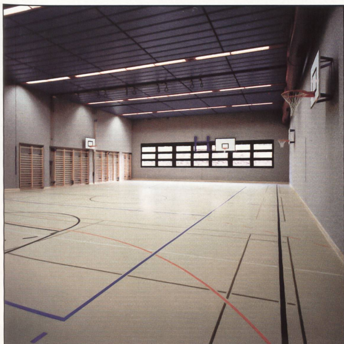
Lehnsturnhallen Winterthur: 2500 m 2 Kugelgarn-Belag «Pamir», Kolorit «Wiesel», verlegt als Wandverkleidung. Nutzschicht 40% Schurwolle, 35% Polypropylen, 25% Schurziegenhaar. Einsatzgewicht ca. 950 g/m 2 . Gesamtdicke ca. 7,5 mm. Latexierter Federrücken.
