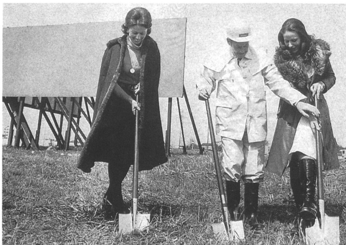
Der erste Spatenstich
