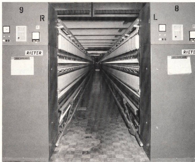
Hier drehen sich 18 500 Spindeln, alle mit Doffer. Die Investitionen für diesen Ringspinnsaal in Aathal betragen 7,5
