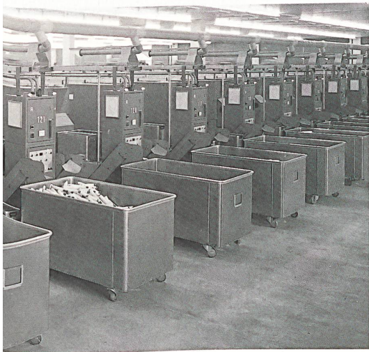
Der grosszügig konzipierte Spinnsaal der Hermann Bühler + Co. AG, Winterthur, mit den vollautomatischen Ringspinnmaschinen gehört heute zu den modernsten Anlagen.
