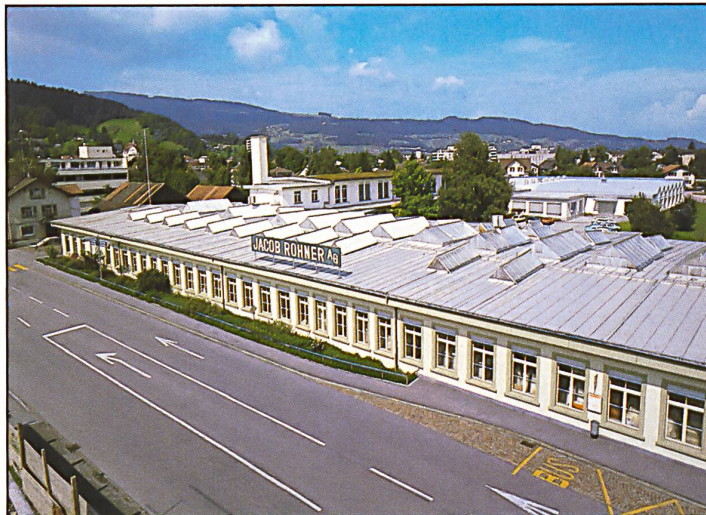
Stickereiwerk Widnau: Im älteren vorderen Teil der Fabrikanlage befindet sich die gesamte Materialvorbereitung, während die Stickmaschinen im hinteren modernen Gebäudeteil (mit Shed) untergebracht sind.
