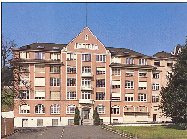
Verwaltungsgebäude Rebstein: Das um die Jahrhundertwende im Jugendstil erbaute und 1982 sorgfältig renovierte Gebäude beherbergt die Zentralverwaltung der Gruppe sowie die Verkaufsadministration und Kreation des Stickereibereichs.
