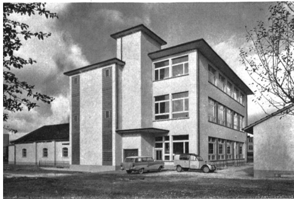
Vista parcial de la fábrica
