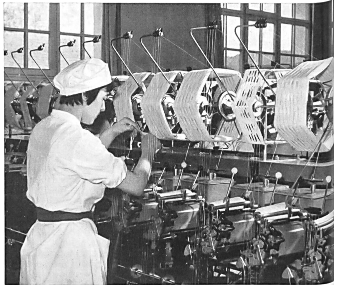
Filé « Hélanca » teint en écheveaux et embobiné sur cônes
