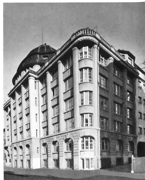
Bâtiment du Laboratoire fédéral d'essai des matériaux et Institut de recherches, Département C, à Saint-Gall
