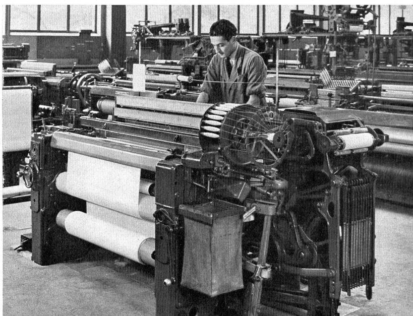
Un métier moderne à ratière avec changeur de canettes à l'école de Zurich.
