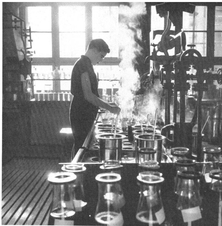
Département des teintures : examen de solidité. Dyes department : fast color testing. Departamento de las tinturas : prueba de solidez. Coloristisches Département : Prüfung der Echtheiten.
