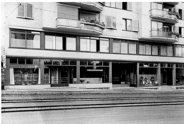
Abb. 20 Die fein detaillierten Türen- und Fensterbereiche des Laden- und Bürogeschosses des «Terminus» (Alpenstrasse 14) in einer Aufnahme von 1936. Auffällig sind die noch nicht befestigte Strasse und die Geleise der Elektrischen Strassenbahn Zug (ESZ).
