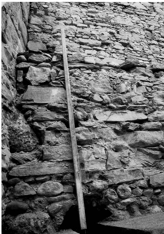
Abb. 15 Quartier Dorf, Blick Richtung Osten. Links der Knopflturm, rechts die nachträglich an den Turm angefügte Stadtmauer. Als Orientierung für die Flucht der Mauer diente der vorstehende Binderstein in der Bildmitte (ähnlich auch weiter unten). Oberhalb und unterhalb dieses Bindersteines zeichnen sich in der Stadtmauerwerk horizontale Baufugen ab, die den sukzessiven Fortgang des Mauerbaues (Bautappen) belegen.
