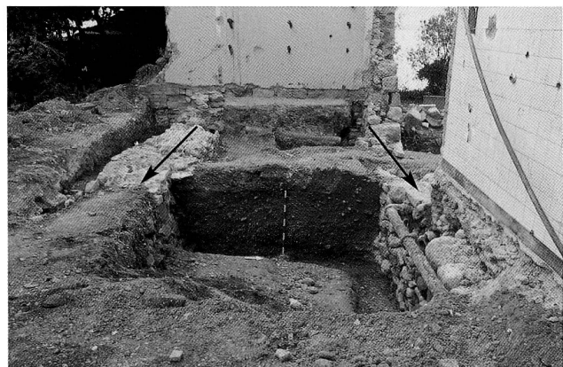
Abb. 8 Haus Santa Maria, Südseite. Mehrphasige Mauerstücke, parallel zur Stadtmauer angelegt (Pfeile).
