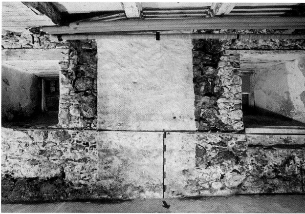
Abb. 4 Seehof, Erdgeschoss, Südostrraum, Blick Richtung Süden. Die teilweise freigelegte Stadtmauer mit zwei jüngeren Fenstern. Der Schnitt Abb. 3 liegt wenig links des linken Fensters.
