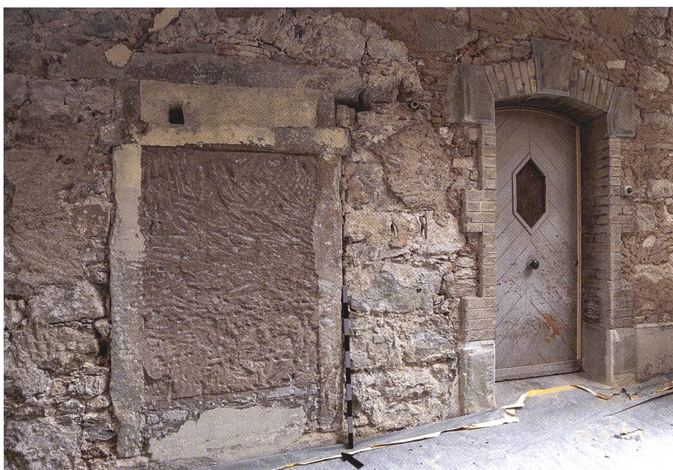
Abb. 25 Zug, Graben 1–2, «Schiff». Beim Abschlagen des Verputzes an der Seite der Gasse kam ein verborgenes Türgewände eines älteren Eingangs zum Vorschein.
