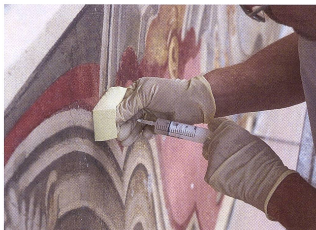
Abb. 2 Der Restaurator beim Einspritzen von Kieselsäureester zum Festigen losgelöster Putzstellen.
