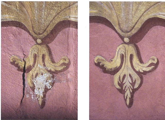
Abb. 3 Detail vor und nach der Restaurierung. Schadensbild am Blattmotiv über dem Haupteingang zwischen den beiden Fenstern des ersten Obergeschosses. Der Riss wurde geschlossen, die Stelle des Hagel-einschlags retuschiert und der rosa Farbhintergrund aufgefrischt.
