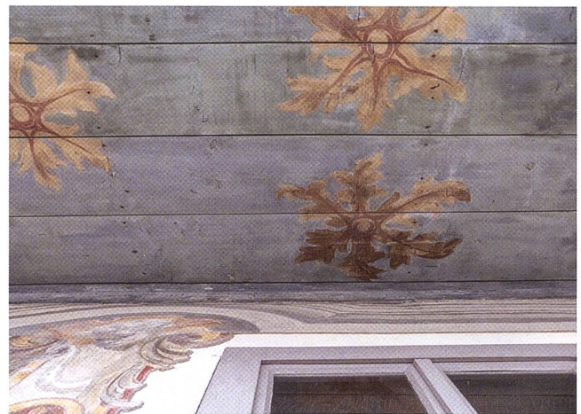
Abb. 4 Die Dachuntersicht vor der Restaurierung. Ersichtlich sind die verblasste und kreidende Farbe, der Grünstich sowie die rostenden Nägel.
