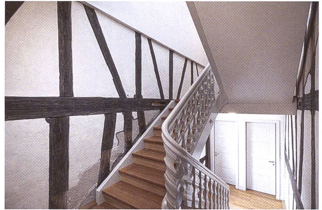
Abb. 2 Die von Restauratoren wieder instand gestellten Fachwerkwände im Treppenhaus.
