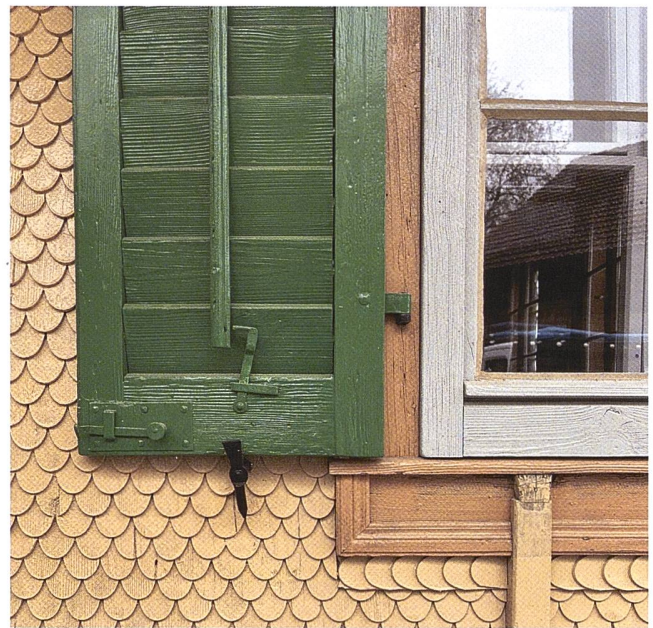
Abb. 4 Detailsicht der Südfassade mit Farbgebung von Schindeln und Holzläden nach Ergebnissen der Farbuntersuchungen.
