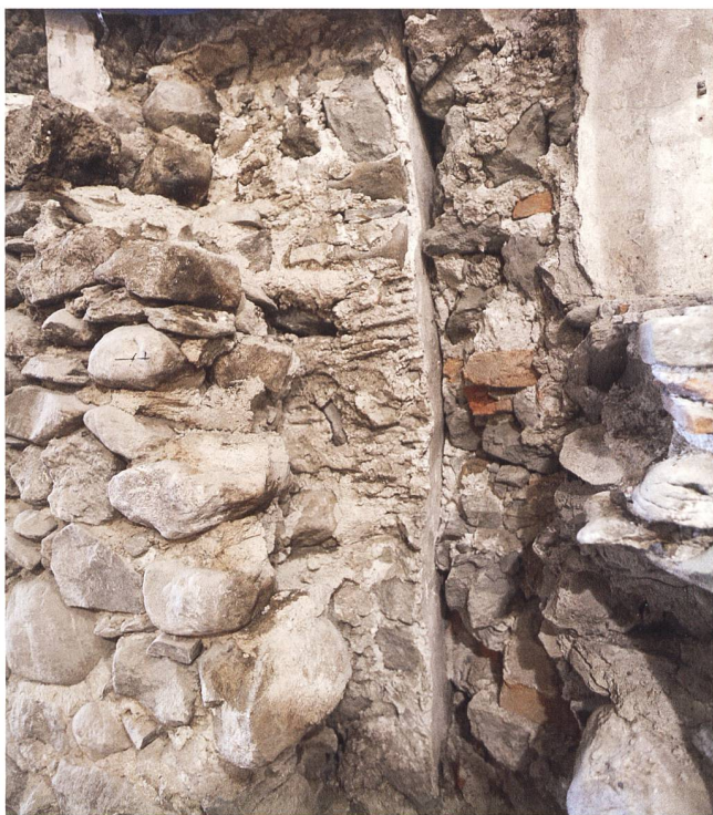
Abb. 8 Nordmauer von Unteraltstadt 24 im Erdgeschoss, Blick Richtung Nord. Bereich des ehemaligen Ehgrabens. Hinter der zum Teil abgebauten Vorblendmauer (vgl. Abb. 2, grün), sind im Mörtel Abdrücke von Routen/Schilfrohr zu erkennen. Die vertikale, mit Mörtel glatt verstrichene Grenze der Mauer markiert den östlichen Rand des einstigen Ehgrabens.
