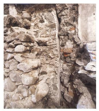
Abb. 8 Nordmauer von Unteraltstadt 24 im Erdgeschoss, Blick Richtung Nord. Bereich des ehemaligen Ehgrabens. Hinter der zum Teil abgebauten Vorblendmauer (vgl. Abb. 2, grün), sind im Mörtel Abdrücke von Routen/Schilfrohr zu erkennen. Die vertikale, mit Mörtel glatt verstrichene Grenze der Mauer markiert den östlichen Rand des einstigen Ehgrabens.
