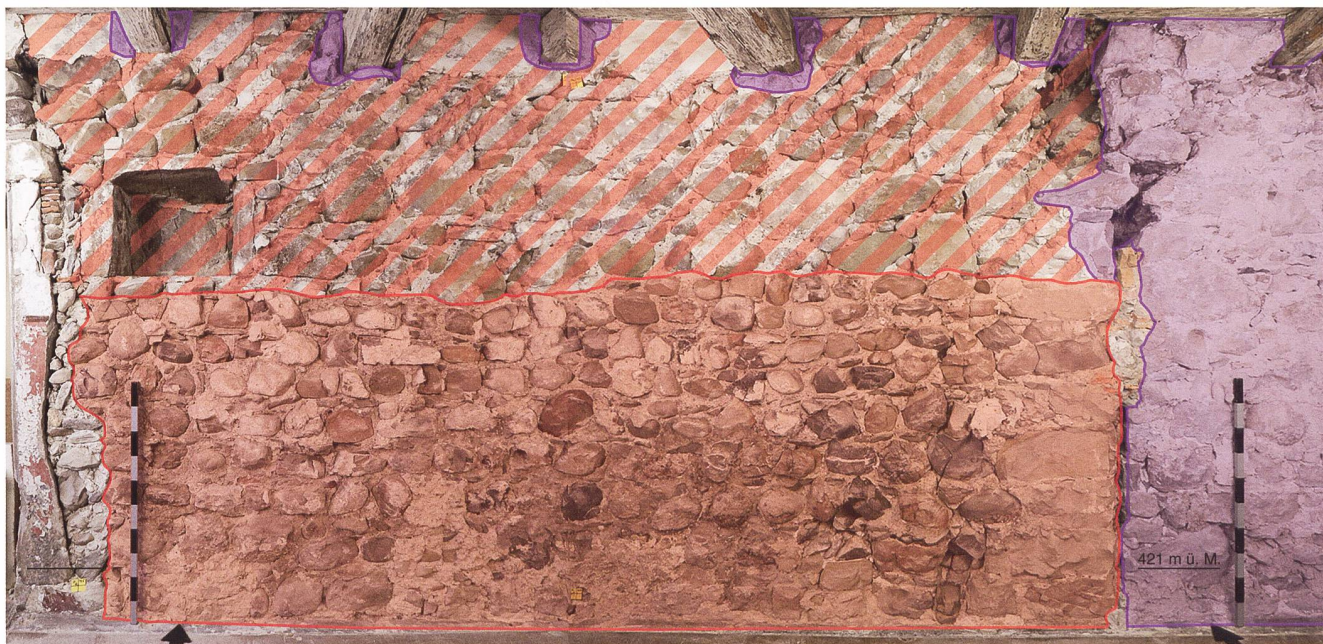
Abb. 3 Die Nordmauer von Unteraltstadt 22 im ersten Obergeschoss, Blick Richtung Nord. Rot bzw. rot schraffiert: Mauerreste von Gebäuden an der einstigen «Untergass». Im unteren Bereich (rot) gehörte die Mauer zu einem Gebäude auf der heutigen Parzelle Unteraltstadt 20, die Aufstockung (rot schraffiert) erfolgte jedoch für ein Gebäude auf Parzelle Unteraltstadt 22. Diese Mauerabschnitte zeigen deutliche Zeichen von einem Brand. Violett: Mauer, die den Ehgraben überbaut. Sämtliche auf der Fotomontage sichtbaren Deckenbalken datieren ins Jahr 1512 und geben damit einen Hinweis auf den spätesten Zeitpunkt der Überbauung des Ehgrabens.
