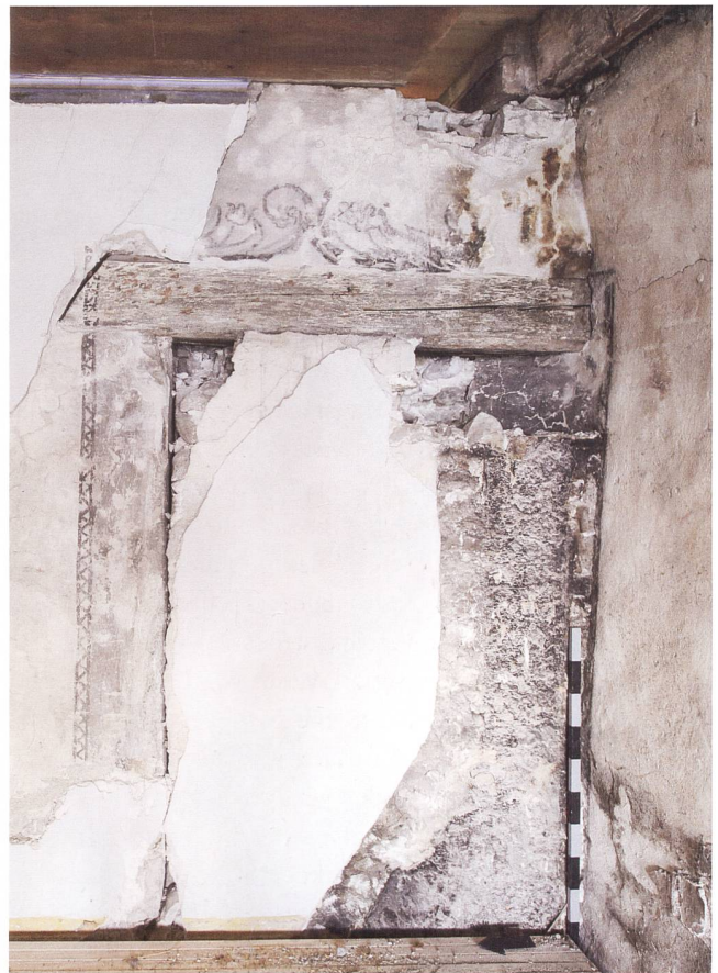
Abb. 6 Durchgang des seeseitigen Raums in den Gangbereich im ersten Obergeschoss. Blick Richtung Ost. Die Graumalerei mit Tulpenmotiv wurde vermutlich im 17. Jahrhundert angebracht.
