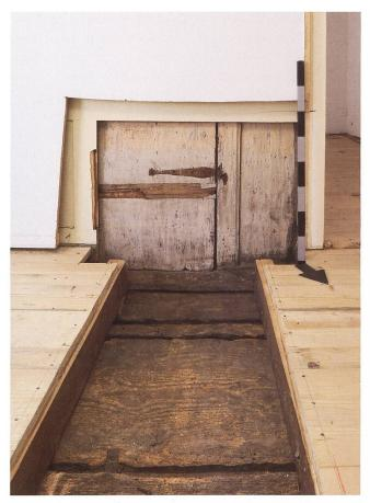
Abb. 5 Unteraltstadt 22, erstes Obergeschoss. Binnenwand auf Bohlenbalkendecke mit erhaltener Türsituation. Blick Richtung Süd.
