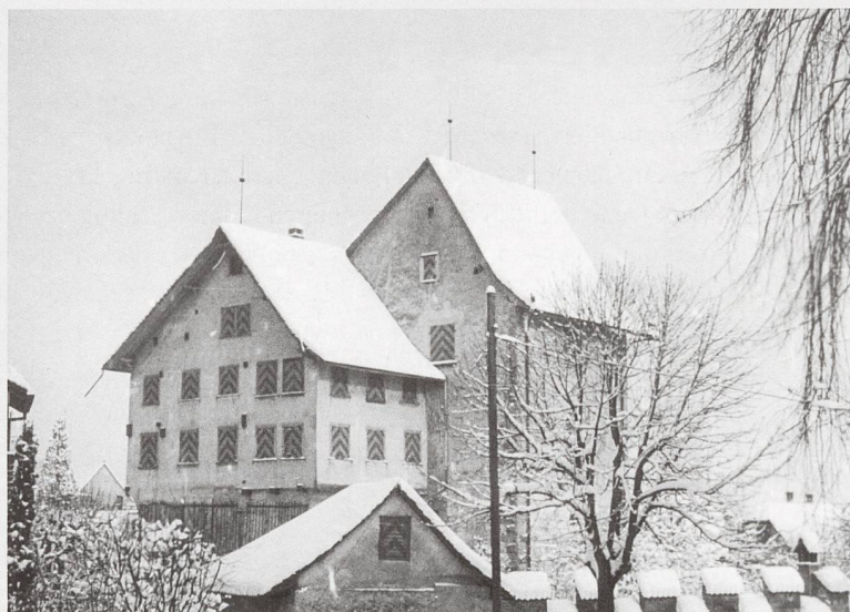
Abb. 1 Die für das Fachwerkgebäude charakteristischen Holzbalken der Burg waren damals noch unter einer Schicht Verputz verborgen und wurden erst später freigespitzt.
