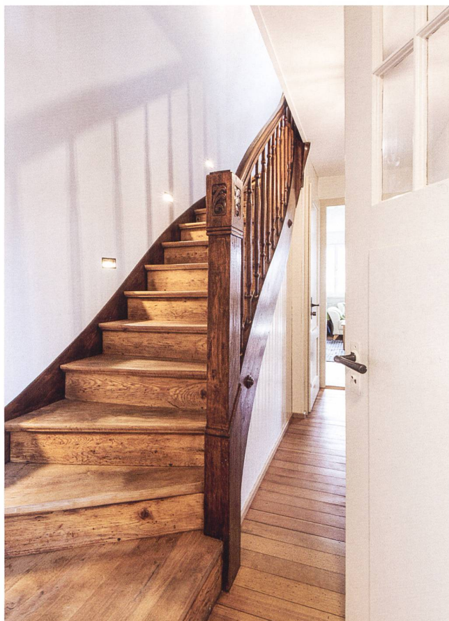
Abb. 15 Cham, Gartenstrasse 16. Bei der Innensanierung wurden Böden und Treppen sorgfältig restauriert und neu geölt, Wandtäfer und Türen mit Leinölfarbe neu gestrichen.
