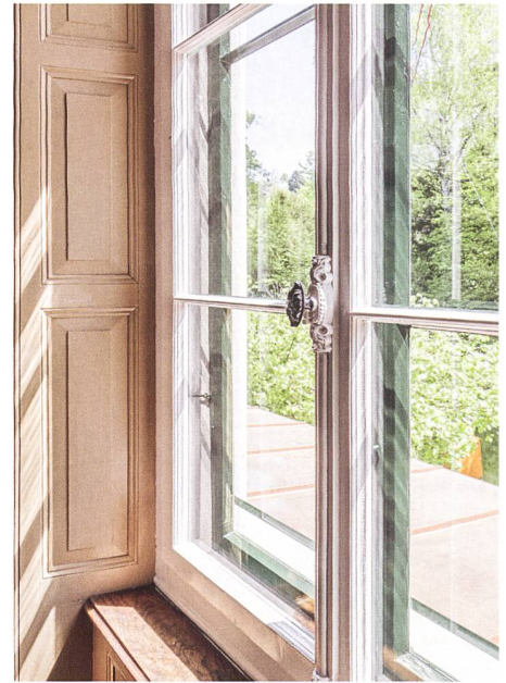
Abb. 4 Die bauzeitlichen Fenster mit ihren zeit-typischen Beschlägen wurden sorgsam aufgearbeitet und mit Isolierglas ausgestattet.
