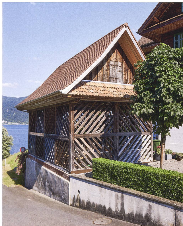
Abb. 30 Risch, Rischerstrasse 23, Holzschopf. Ansicht von Nordwesten. Der neu restaurierte Holzschopf neben dem Pfarrhaus stammt aus dem ersten Viertel des 19. Jahrhunderts und trägt, als einziges erhaltenes historisches Nebengebäude, zur typologischen Vielfalt des ehemals bäuerlichen Kirchweilers Risch bei.
