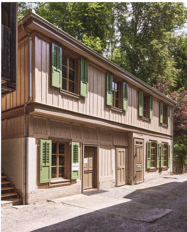
Abb. 29 Menzingen, Schönbrunn, Werkstattgebäude. Ansicht von Nordwesten. Bei der sanften Restaurierung des Gebäudes wurden nicht nur Mauerwerk und Holzverschalung saniert und repariert, sondern auch Türen, Fenster, Fensterläden und Gitter blieben erhalten und wurden nach historischem Befund wieder neu gefasst.
