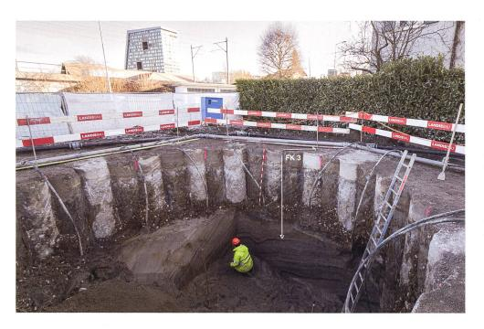
Abb. 46 Zug, Quartier Herti, Regenwasserableitung Stierenmarktareal. Arbeitssituation in Schacht 2 mit Blick gegen Nordost, im Hintergrund das Uptown-Hochhaus. Kathrin Rüedi präpariert das Profil, die hierin aufgeschlossenen Vorschüttsande des alten Lorzedeltas sind gut erkennbar. Die <sup>14</sup>C-datierte Makrorestprobe FK 3 stammt aus der dunklen Strate rechts ihrer Schulter.
