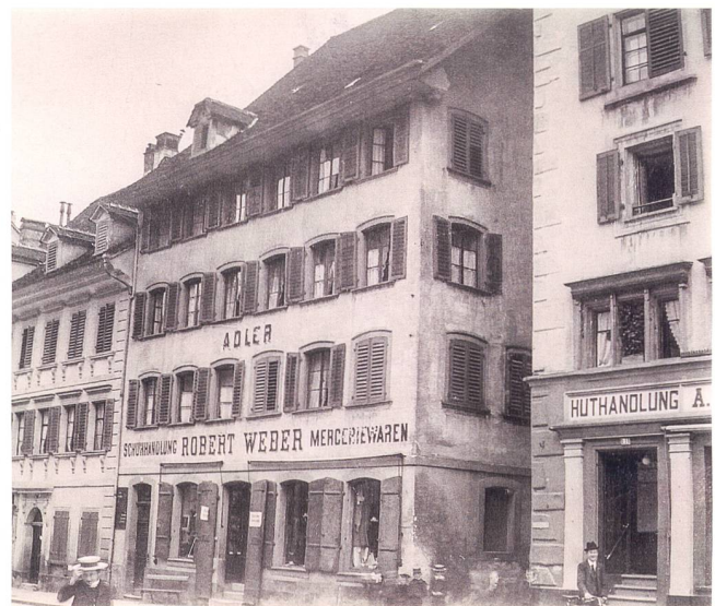
Abb. 42 Zug, Neugasse 29. Aufnahme der Hauptfassade aus der Zeit vor 1904.
