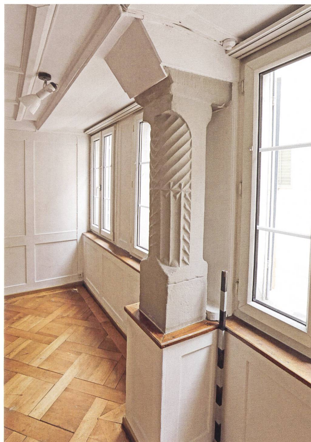
Abb. 49 Zug, Zeughausgasse 13. Die Fenstersäule aus Sandstein stammt aus dem 16. Jahrhundert. Die übrige Ausstattung der Stube im ersten Obergeschoss stammt mehrheitlich aus dem 19. Jahrhundert.
