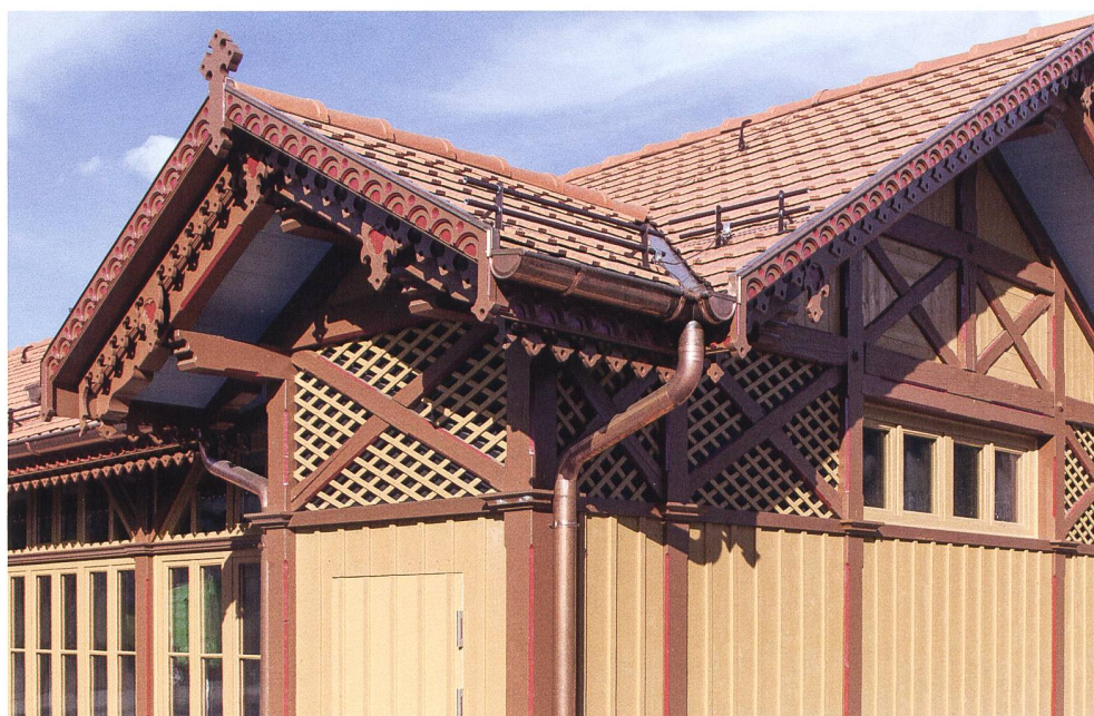
Abb. 50 Zug, Zugerberg, Schönfels 5. Das Holzwerk wurde sorgfältig demontiert und nach der Restaurierung in der Werkstatt, um nötige Ersatzteile ergänzt, vor Ort wieder aufgebaut.
