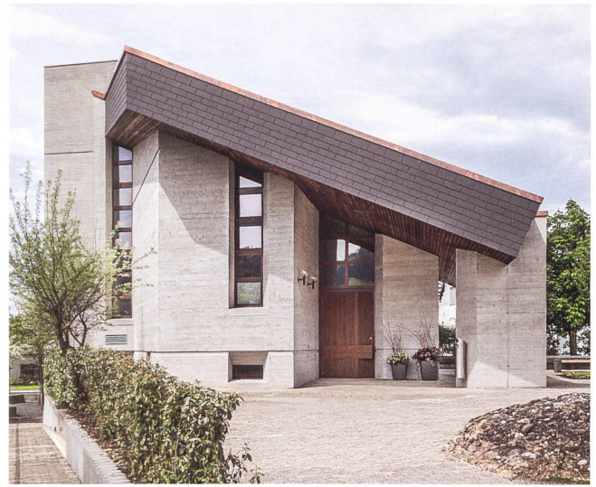
Abb. 2 Aussenansicht von Süden mit Vorplatz und Eingangssituation. Mit der Betonsanierung erhielt das durch frühere Massnahmen verunklärte Fassadenbild wieder einen einheitlichen Ausdruck.
