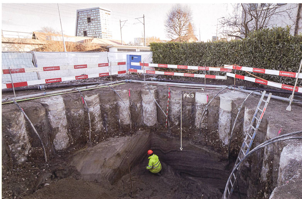
Abb. 46 Zug, Quartier Herti, Regenwasserableitung Stierenmarktareal. Arbeitssituation in Schacht 2 mit Blick gegen Nordost, im Hintergrund das Uptown-Hochhaus. Kathrin Rüedi präpariert das Profil, die hierin aufgeschlossenen Vorschüttensande des alten Lorzedeltas sind gut erkennbar. Die 14 C-datierte Makrorestprobe FK 3 stammt aus der dunklen Strate rechts ihrer Schulter.
