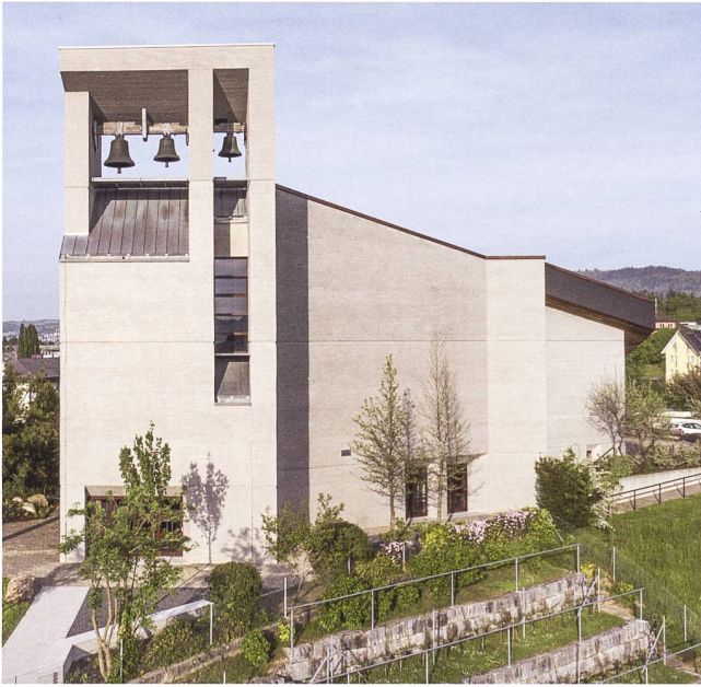
Abb. 1 Risch, Reformierte Kirche Rotkreuz. Ansicht von Westen. Der Kirchturm mit offenem Geläut wächst gewissermassen aus dem Kirchenraum heraus.
