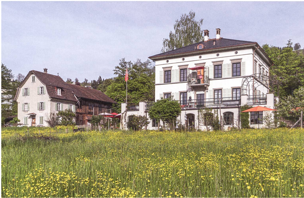
Abb. 1 Zug, Kirchmattstrasse 1. Die repräsentative Villa Marchand erstrahlt nach einer sorgfältigen Fassadensanierung in neuem Glanz.
