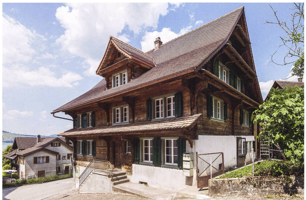
Abb. 37 Walchwil, Dorfstrasse 13. Ansicht von Osten. Hinter den sanft renovierten Fassaden des Blockbaus entstanden neu zwei voneinander unabhängig funktionierende Wohnungen nach zeitgemäßem Standard.
