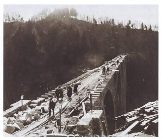
Abb. 10 Blick auf die Baustelle der 186,5 Meter langen, steinernen Lorzentobelbrücke bei Menzingen, die mit ihren Massen im Vergleich zu den im 19. Jahrhundert realisierten Brückenbauten in neue Dimensionen vorstiess. Fotografie, um 1908.
