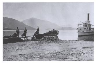
Abb. 6 Das benötigte Kies für den Strassenbau musste zur Baustelle transportiert werden. Im Bild ist der Antransport von Kies und Sand mit dem Ledischiff Delphin in Zug zu sehen. Teilweise kam es auch zu Kies-Absteigerungen: Dabei wurde es dem Mindestfordernden überlassen, das «Grien» innert einer gewissen Frist in bestimmten Quantitäten auf angegebenen Strassenstrecken abzuladen. Fotografie, um 1900.
