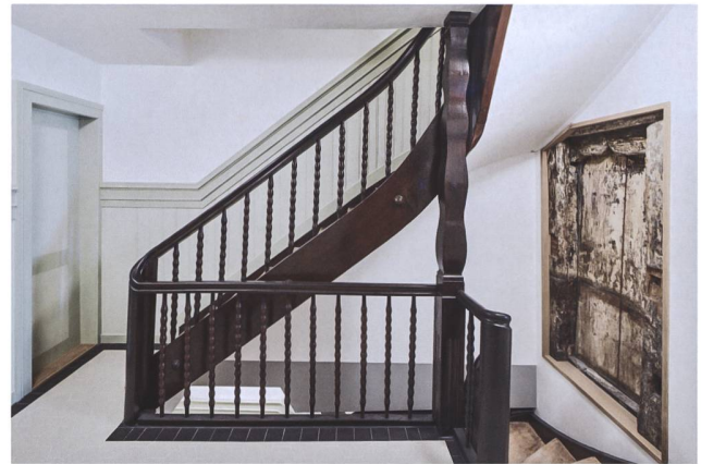
Abb. 4 Im umsichtig renovierten Treppenhaus sind drei Bauphasen gleichzeitig zu sehen: die gotische Türöffnung, die barocke Treppenanlage und das Krallentäfer aus dem 19. Jahrhundert.
