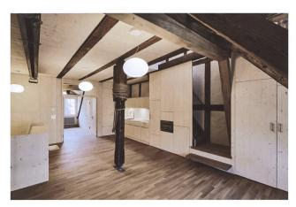
Abb. 3 Einblick in die grosszügige Dachwohnung im ehemaligen Estrich des Hauses. Historisches Dachwerk, Fachwerkwand, Estrichtreppe und Lastenaufzug mit Winde bleiben erhalten.
