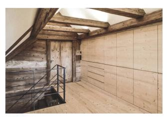
Abb. 4 Dachgeschoss mit Blockwand und historischer Türe und teilweise sichtbarem Dachstock.
