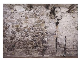
Abb. 4 An der westlichen Nordwand im 1. Obergeschoss sind links ein älterer, durch Brand geröteter Mauerabschnitt und die sekundär eingebauten Deckenbalken von 1512d zu sehen.
