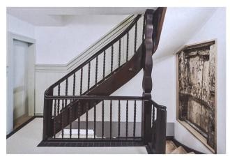
Abb. 4 Im umsichtig renovierten Treppenhaus sind drei Bauphasen gleichzeitig zu sehen: die gotische Türöffnung, die barocke Treppenanlage und das Krallentäfer aus dem 19. Jahrhundert.
