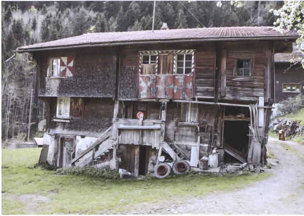
Abb. 2 Das «Wyssighaus» im Isenthal wurde vor seiner Demontage für einen Wiederaufbau an einem neuen Standort bauarchäologisch untersucht. Die dendrochronologische Datierung ergab ein Fälldatum im Winterhalbjahr 1787/88. Blick auf die östliche Trauffassade.
